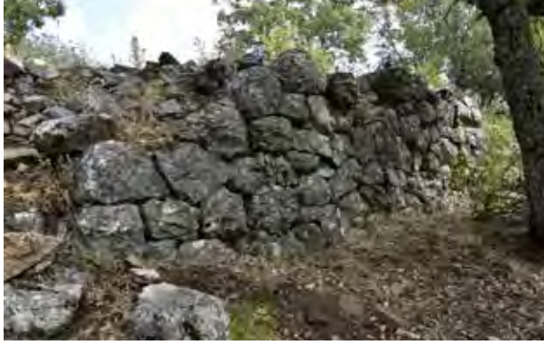
9. B Bölgesindeki tepenin güneyindeki teras duvarı.
