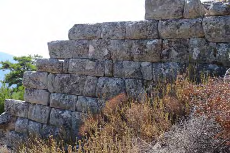
Resim 7: 6 nolu kule ve kulenin doğu duvarı.
