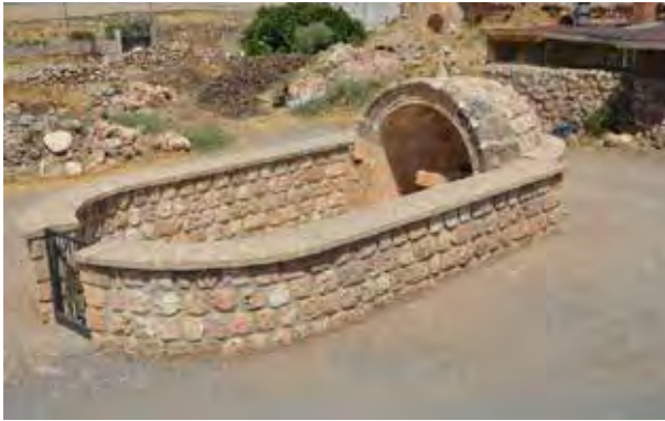
Resim 15: Kadışto Abriyo Kilisesi, genel görünümü
