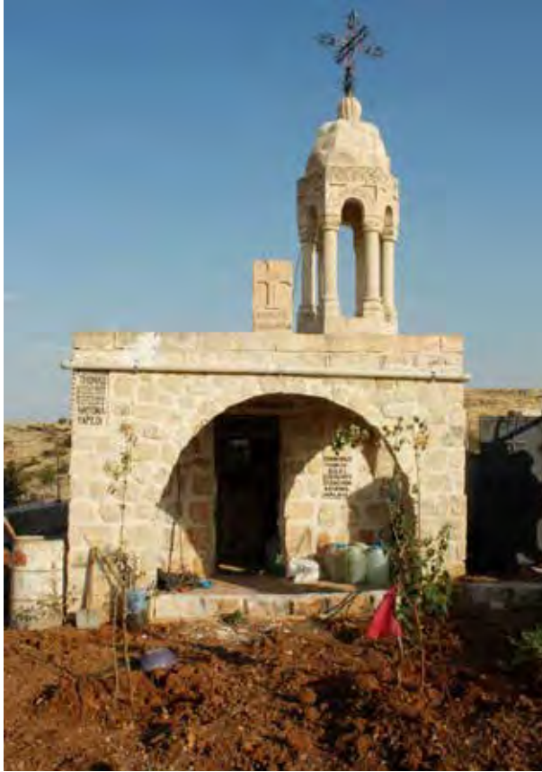
Resim 5: Kadişto Fabroniya Şapeli, güneybatı cepheden görünümü.
