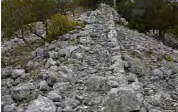
7. A Bölgesindeki kale duvarı örgüsü.
