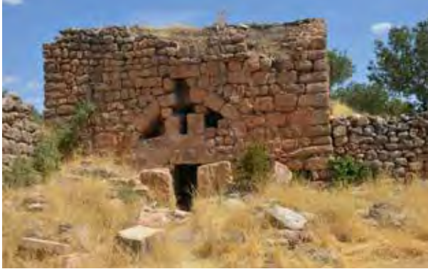
Resim 8: Mor Aho (Deyr Hadad) Kilisesi, batıdan görünüm.
