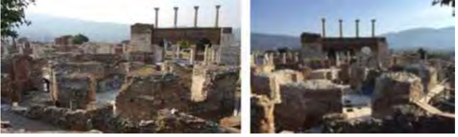
Resim 4: Vaftizhane acil onarım çalışmaları öncesi ve sonrası genel görünümü.
