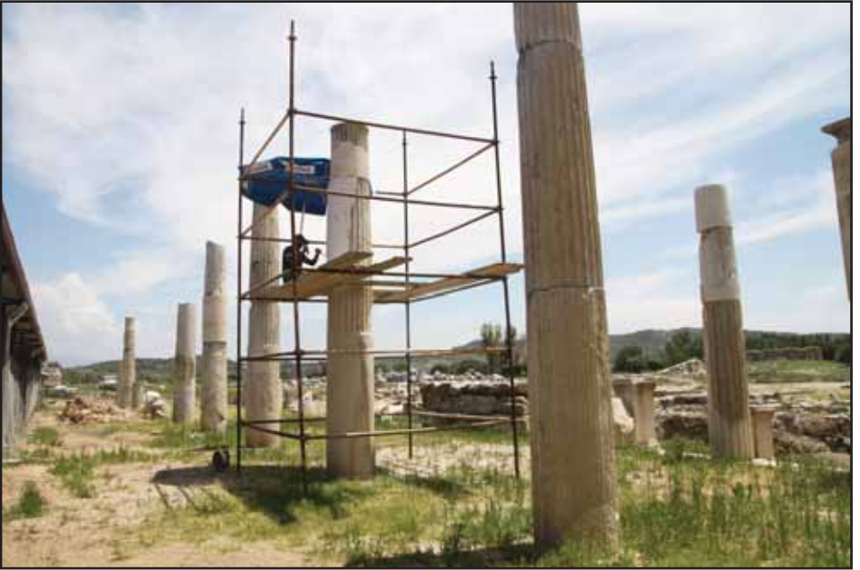
Resim 4: Kuzey stoa restorasyon çalışmaları.
