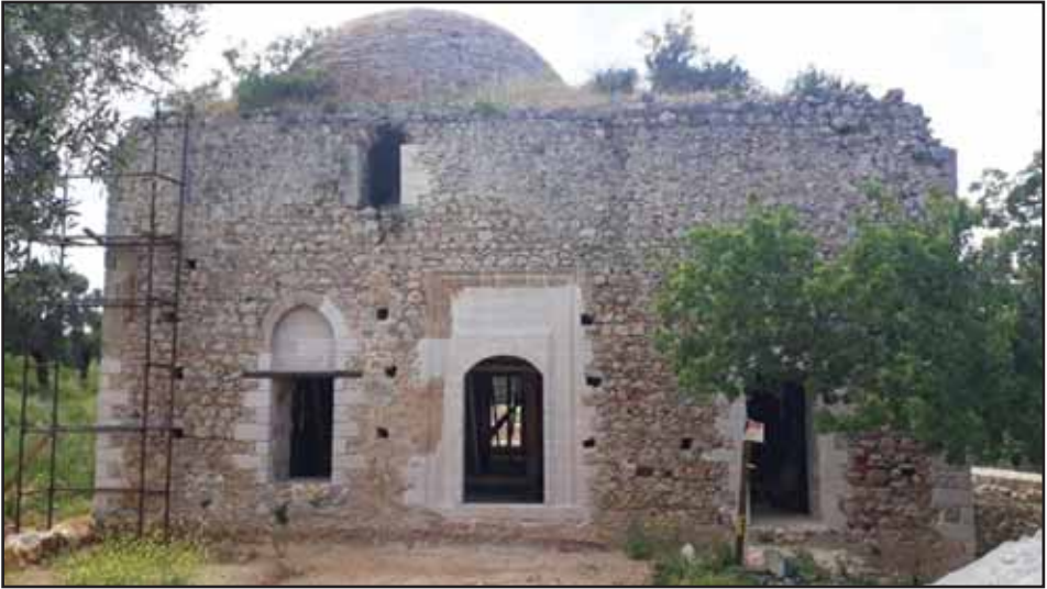
Resim 7: Yelli Cami batı ve güney cephe uygulama sonrası.
