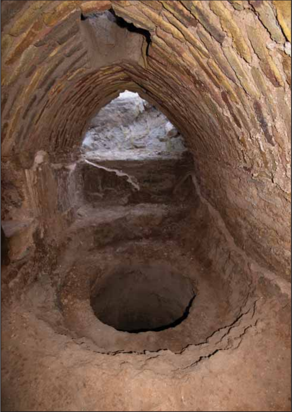
Resim 9: Sıcak su deposu ve k lhanın metal kazanının konulduđu kısmın g r n m , Saray Hamamı.
