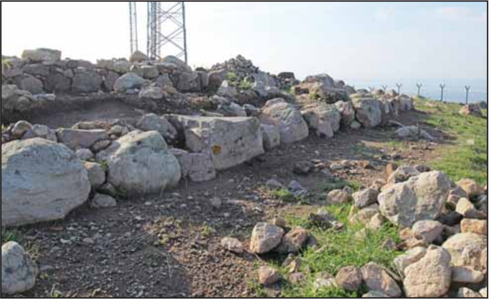
Resim 8: Foça, Çan Dede Tepesi tapınaklar alanı. Megaron biçimindeki III No.lu tapınağın kuzey temenos duvarı.
