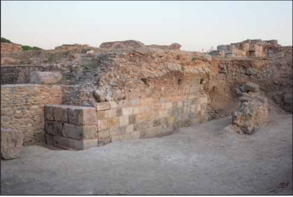
Resim 8: Kuzey duvar restorasyonu.
