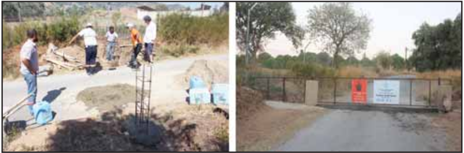
Resim 12: Tralleis antik kentine dış kapı yapılması.
