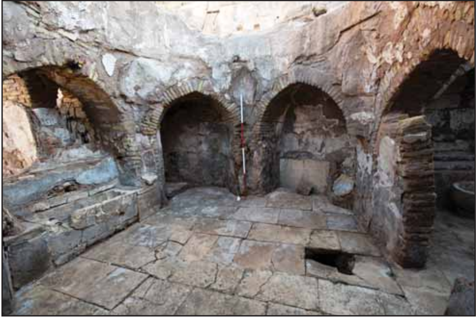
Resim 8: Sıcaklık 1'in içten güneyden görünümü, Saray Hamamı.
