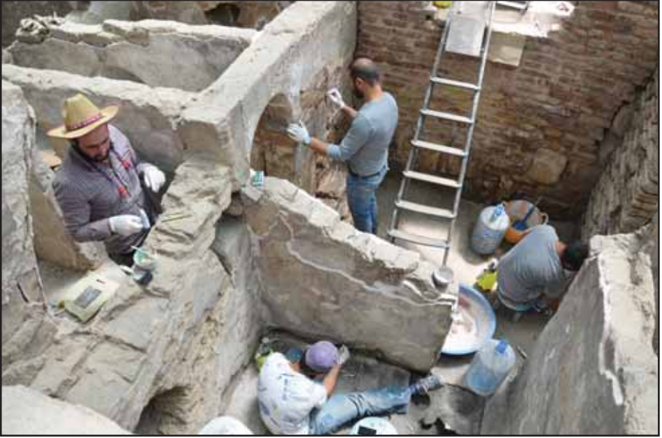
Resim 1: Restorasyon ve konservasyon çalışmalarının görünümü, Çarşı Hamamı.
