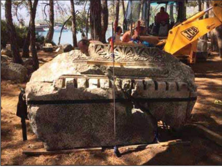
Resim1: Hadrianus Kapısı restorasyon çalışmaları.
