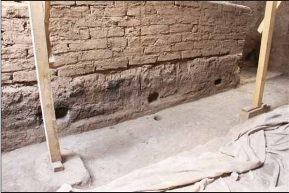
Resim 8: A Açması E 28 gridinde tespit edilen ahşap yuvaları.
