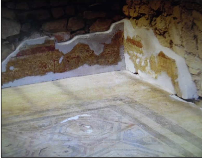
Resim 5: Temizleme sonrası görünümü. (Metropolis).
