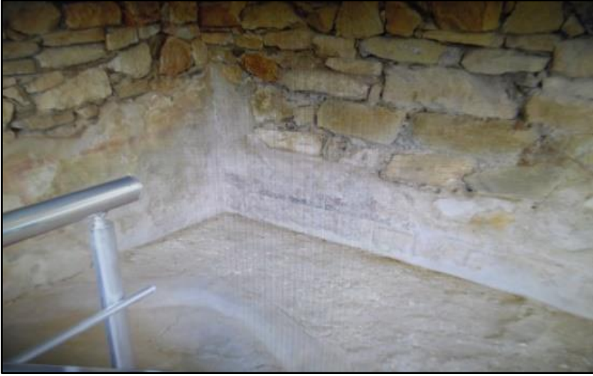
Resim 8: Onarım sonrası görünümü. (Metropolis).
