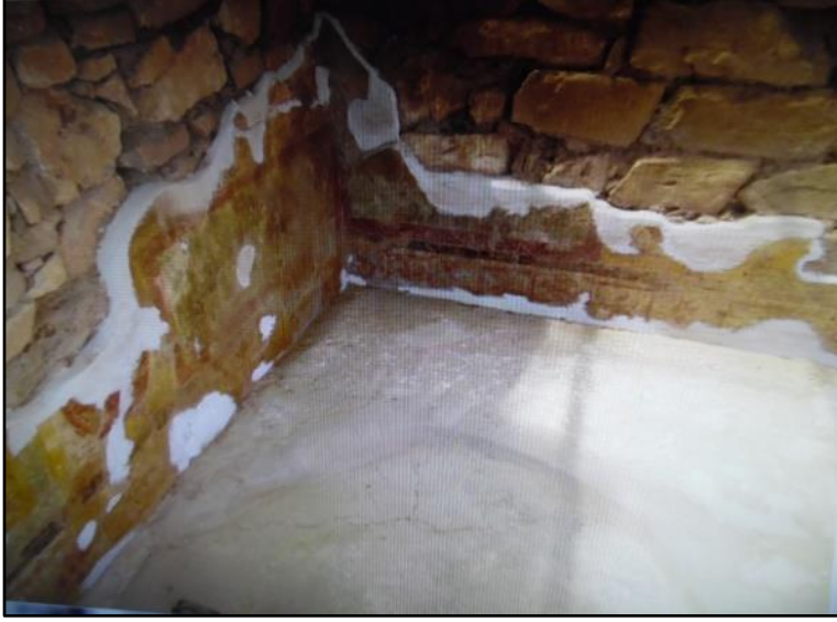
Resim 7: Temizleme sonrası görünümü. (Metropolis).
