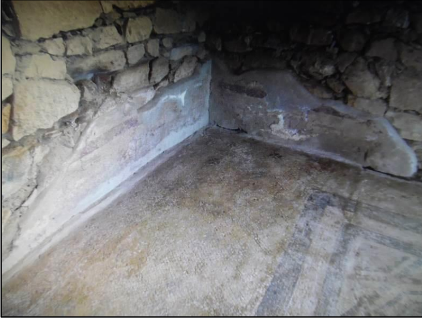
Resim 6: Onarım sonrası görünümü. (Metropolis).
