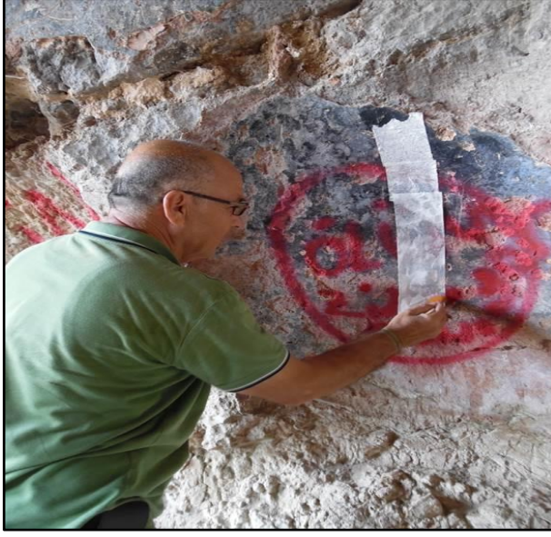
Resim 9: Boya kirliliğinin çözücü ile yumuşatılması. ( Kaya Kilisesi).
