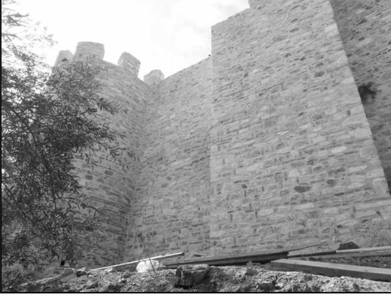
Resim 2: Ayasuluk Kalesi kuzeydoğu sur duvarları 8. kulenin bir bölümü, 7-8. kuleler arası ve 8. kule derz sağlamlaştırma çalışmaları sonrası görünümü.
