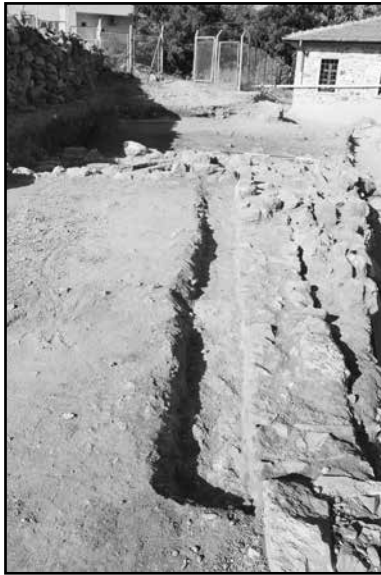
Resim 2: İstinat duvarının açılan kısmı.
