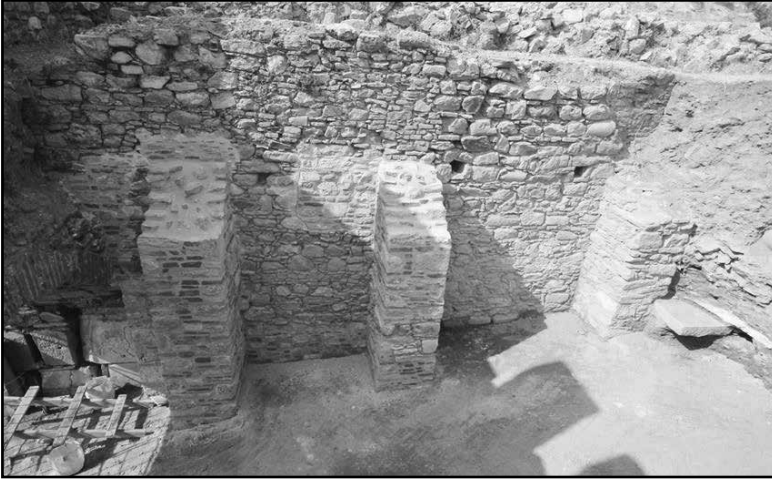
Resim 5: İç Kale doğu sarnıçlarının kuzey cephe duvarını destekleyen payandaların koruma onarım çalışmaları sonrası görünümü.
