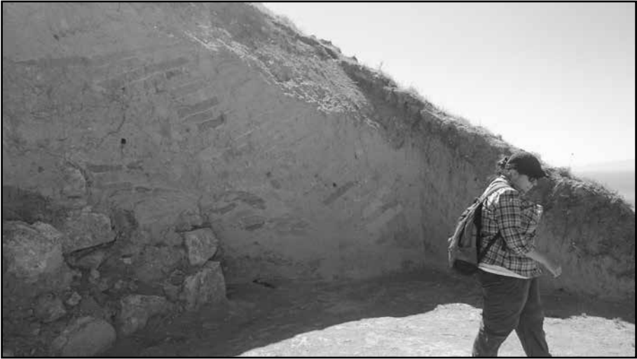
Resim 2: Kuzuydoğu sur duvarlarının yıkılan kerpiç blokları.
