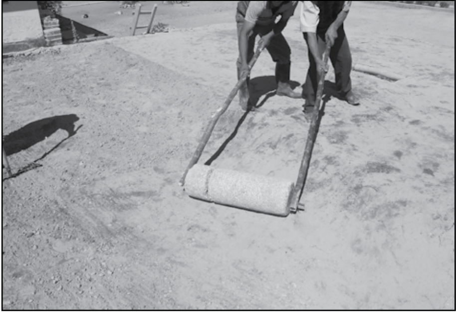
Resim 11: Loğ taşı ile yapılan sıkıştırma işlemi.
