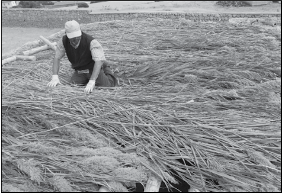
Resim 10: Kirişlere dik yerleştirilen saz demetleri.
