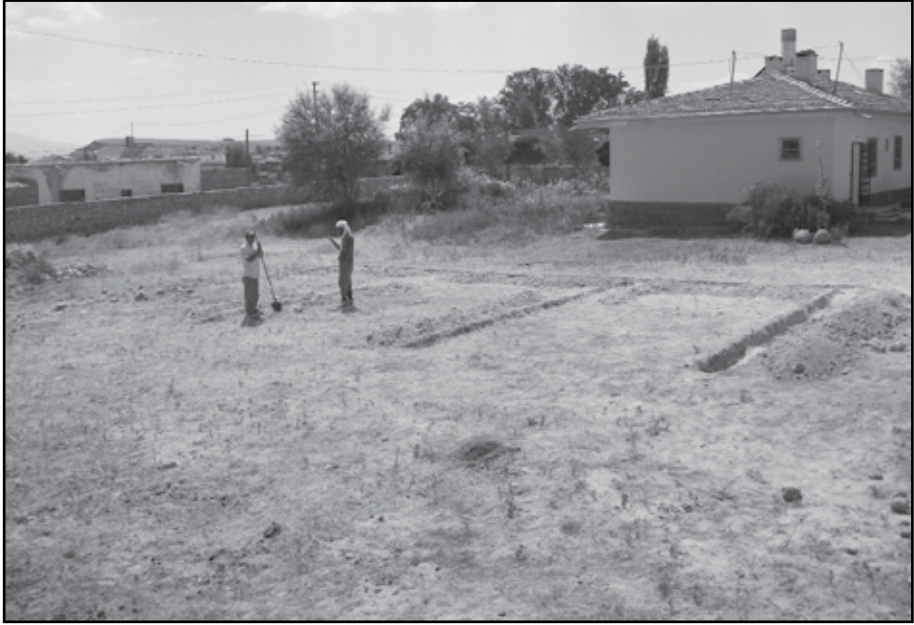
Resim 3: Deneysel yapıların temel kazısı.
