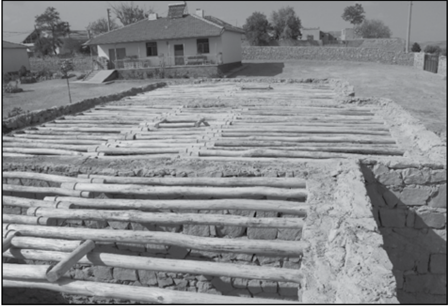
Resim 9: Kirişlerin duvar içine gömülerek sabitlenmesi.
