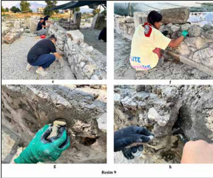
Resim 9: Kilise, Duvarlardaki Koruma Onarım Uygulaması
