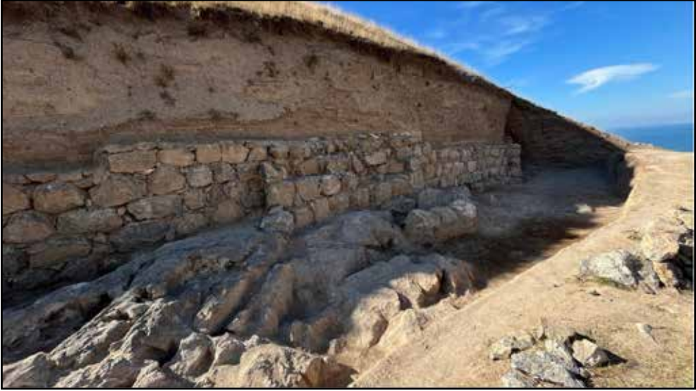
Resim 11: Kuzeydoğu sur duvarının kuzeyden görünümü.
