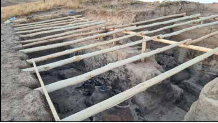
Resim 13: Pithoslu alanın çatı ile koruma çalışması
