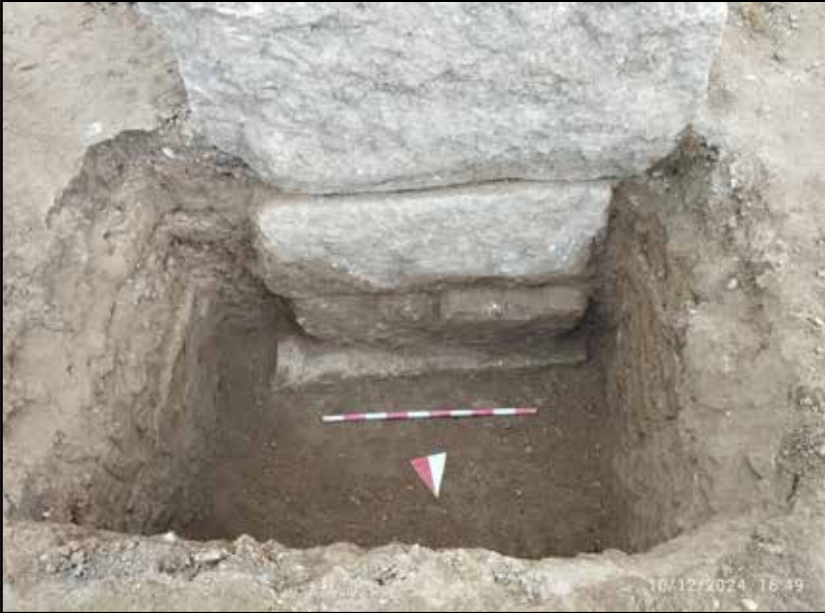
Resim 7: 20. Kemer ayağında devam eden bosajsız blok taşlar.
