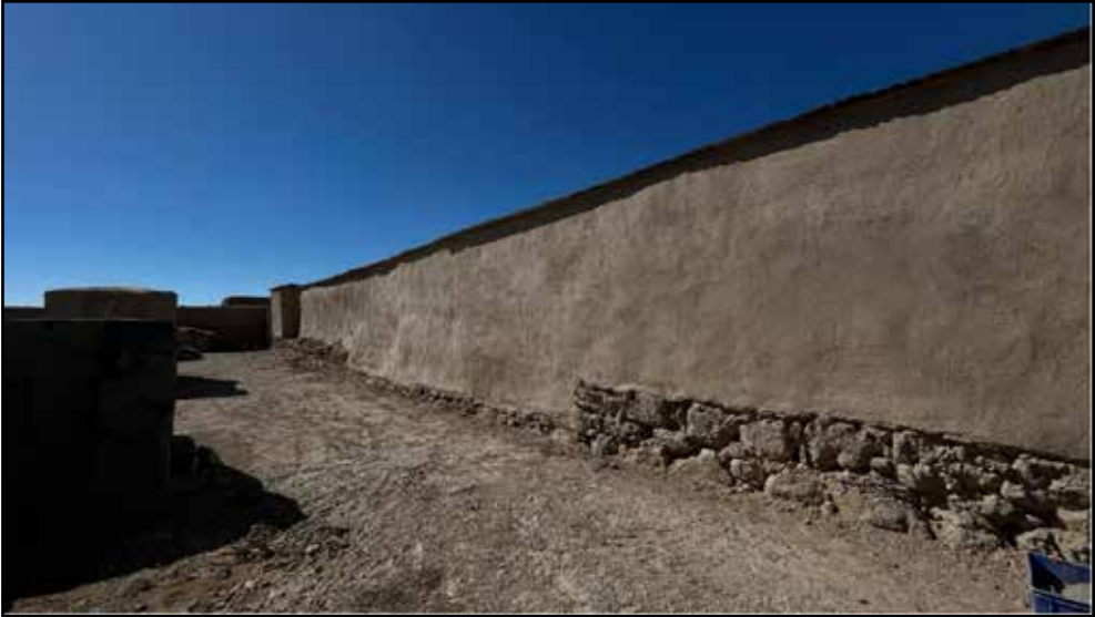
Resim 12: Tapınak avlusunun sıvanma işlemi.
