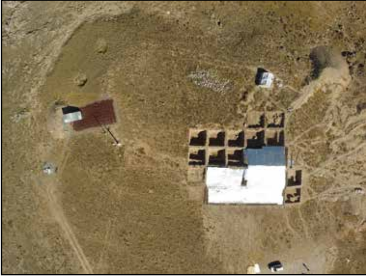
Resim 14: Pithoslu alan ve tünel girişinde yapılan çatı ve membran işlemleri
