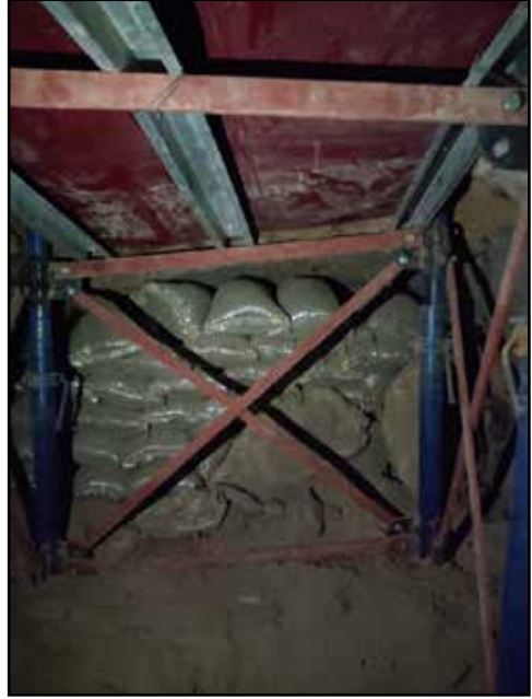
Resim 15: Kaçak kazı tünelinin çakıl dolu torbalar ile kapatılması ve demir iskelet yapımı
