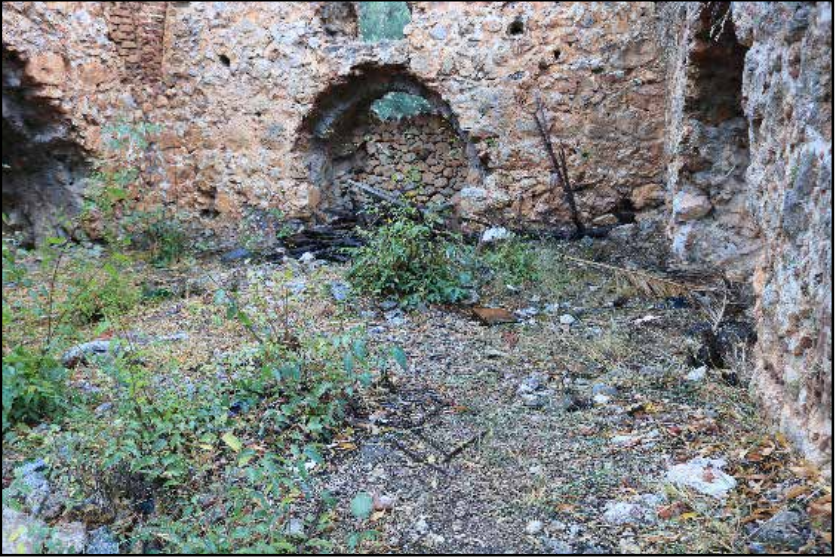
Resim 13: 11 Numaralı kule, kazı çalışmaları öncesi.
