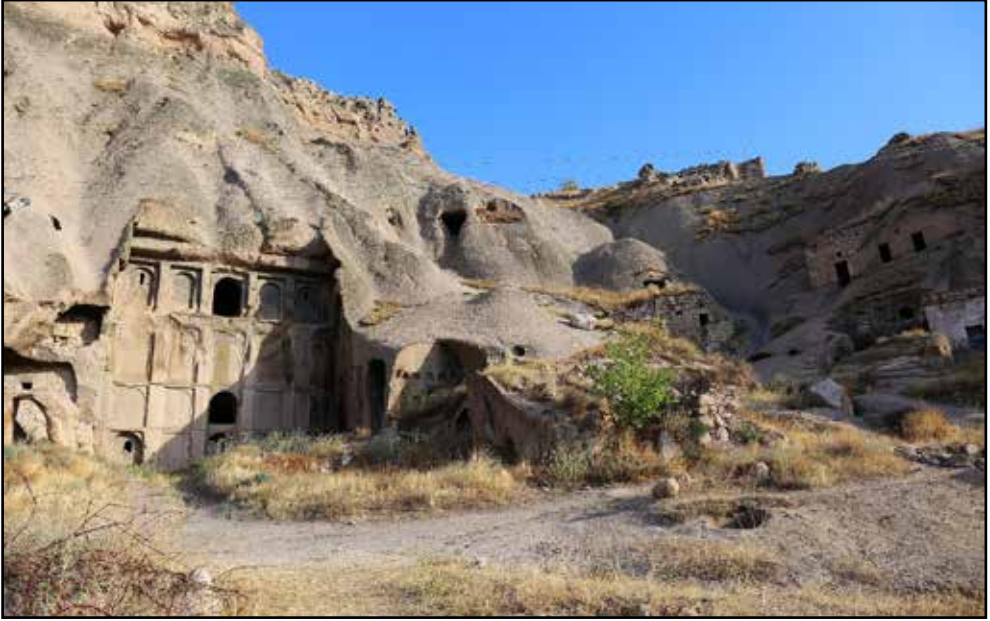
Resim 8: 4 No.lu Yapı Kompleksi, avlu ve cephe düzenlemesi
