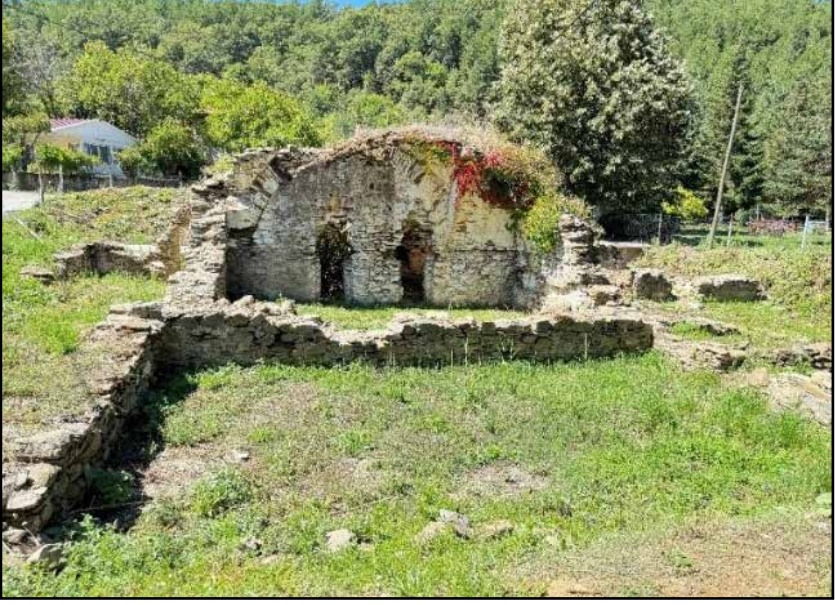
Resim 5: Köyiçi Mevkii 343 Ada 6 Parsel'de yer alan hamam yapısı, doğu cephesi
