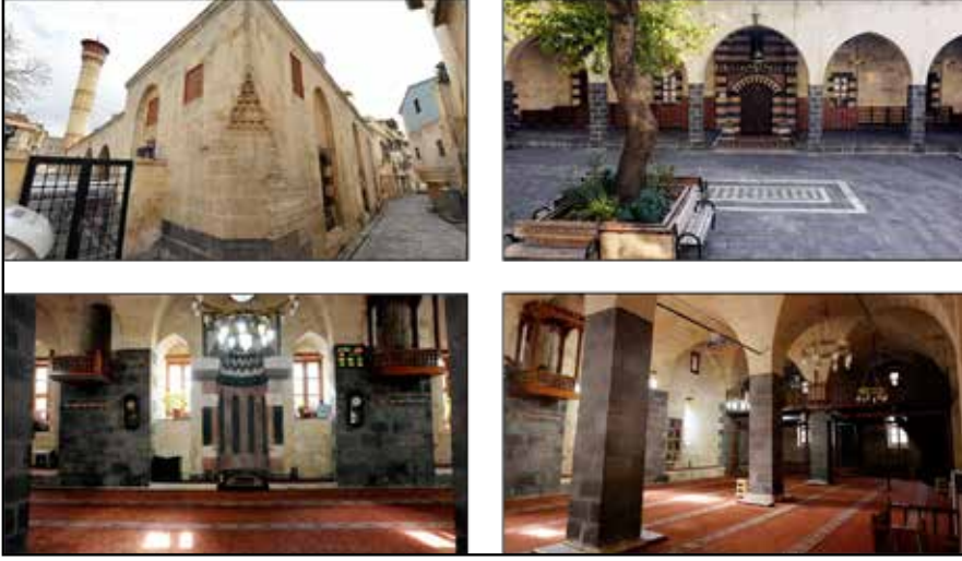
Şekil 1a: Gaziantep Eyüpoğlu Camii'nin Kahramanmaraş depremleri öncesine ait görüntüleri
