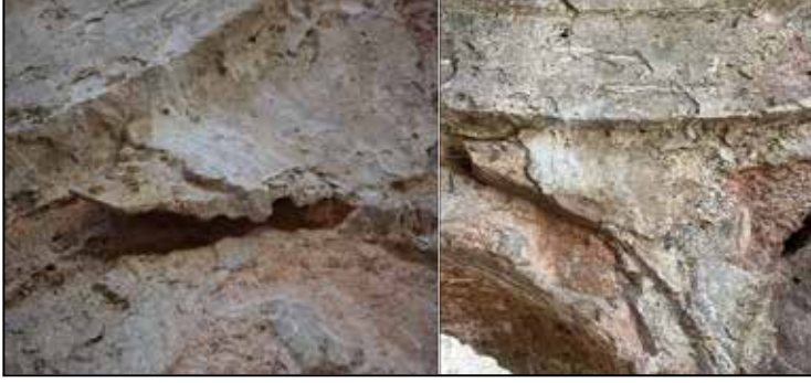
Resim 10: Osmanlı Hamamı sıva boşluklarında enjeksiyon uygulaması
