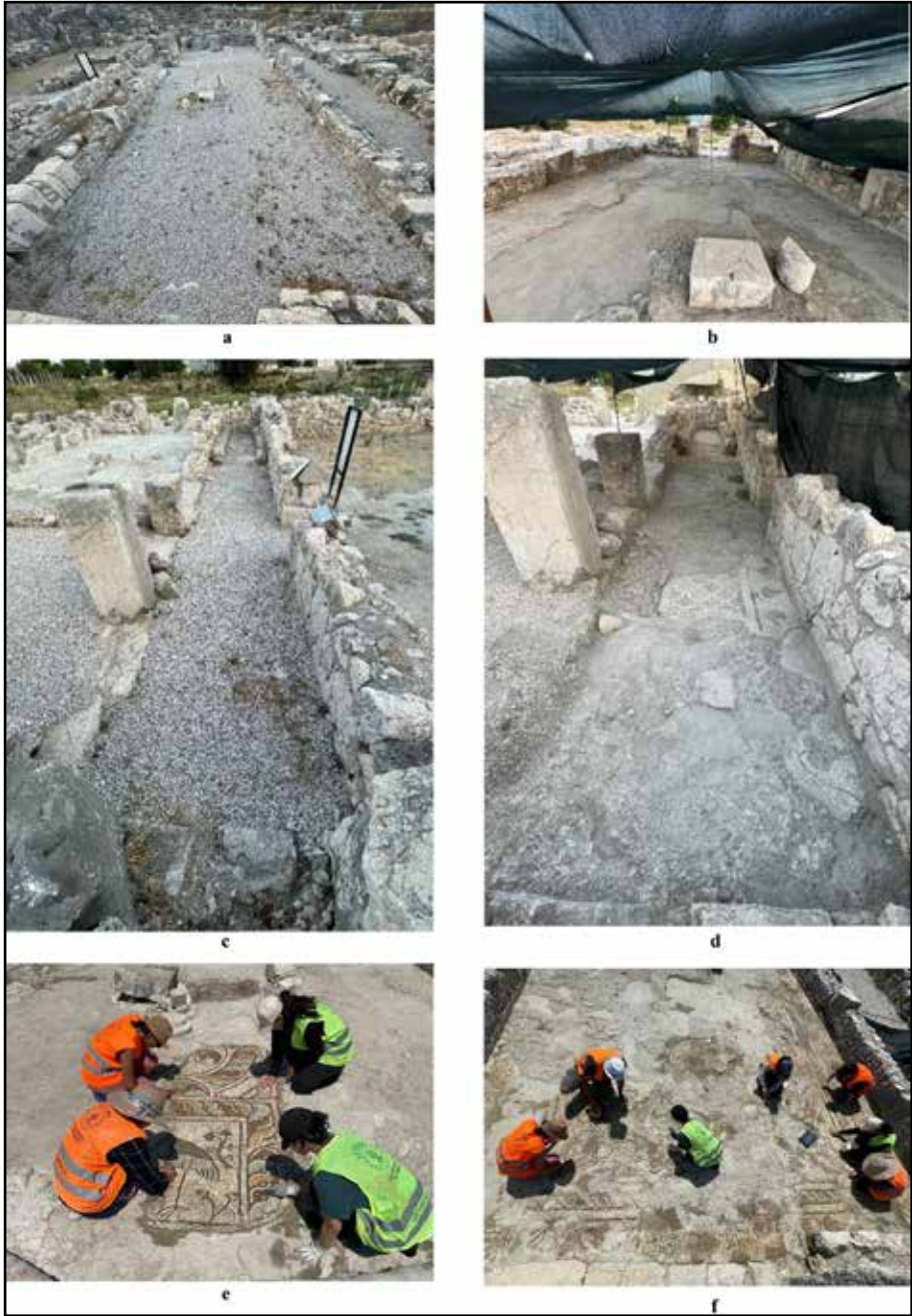
Resim 5: a, b- Kilise, Orta Nef, Çalışmalar Öncesi c, d- Kilise, Orta Nef, Çalışmalar Öncesi e, f- Kilise, Orta Nef, Kuru ve Islak Mekanik Temizlik Çalışmaları
