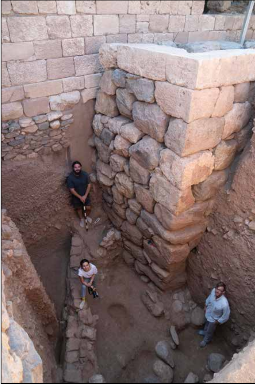
Açma F49 24.1'in görünümü (Lidya duvarının üç evresi ve arkada Hellenistik dönem duvarı) / View of trench F49 24.1 showing three phases of Lydian wall, and Hellenistic wall behind.
