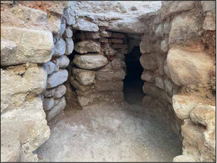
Resim 4: Türk Hamamı ısıtma sistemi giriş ve ocak kısmı.
