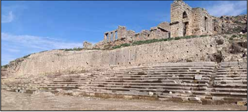
Resim9: Stadion Doğu Tribünü ve Analemma duvarının basit onarım çalışmaları sonrası durumu.
