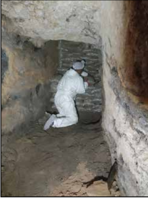
Resim 15: Kaçak kazı tünelinin çakıl dolu torbalar ile kapatılması ve demir iskelet yapımı
