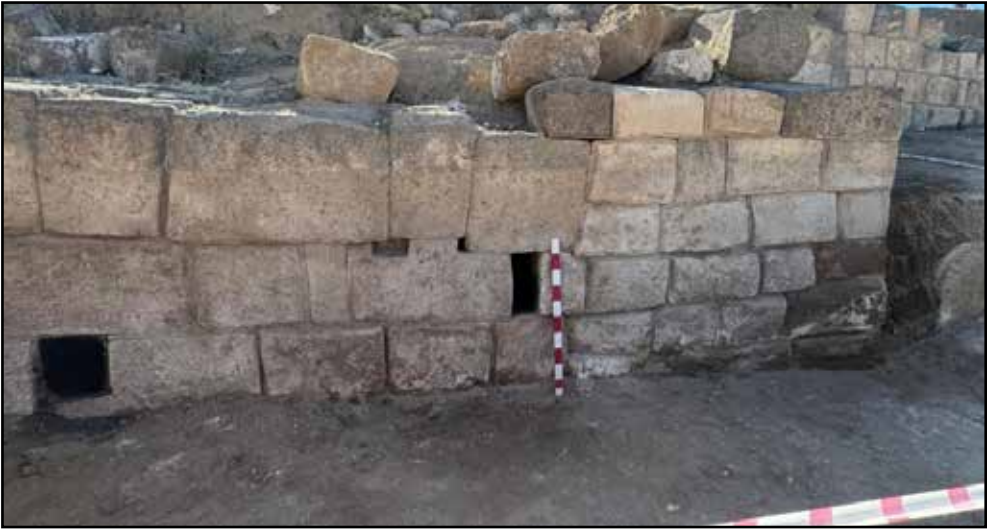
Resim 8: AF48-C Plankaresi içerisinde bulunan surların üzerinde drenaj kanalı.
