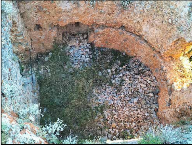
Resim 9: 8 Numaralı kule, kazı çalışmaları öncesi.
