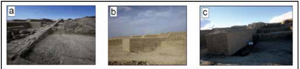
Resim: 12a-c Yapı II-Yapı III ara duvarının a: Temizlik, geçici koruma ve onarım çalışmaları öncesi görünümü, b: Kerpiç çalışmaları sonrası görünümü, c: Sıva çalışmaları sonrası görünümü.
