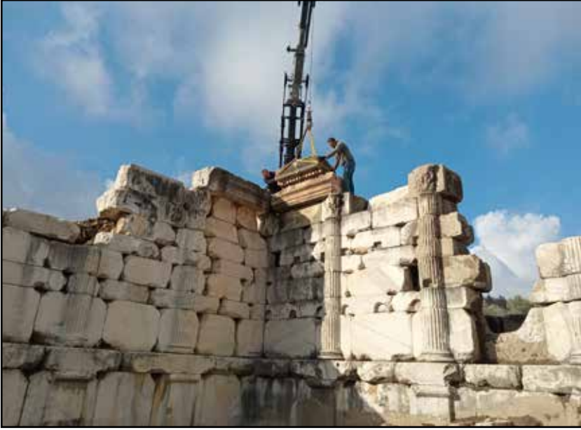
Resim 6: Gymnasion kuzey duvarında yapılan anastylosis çalışması
