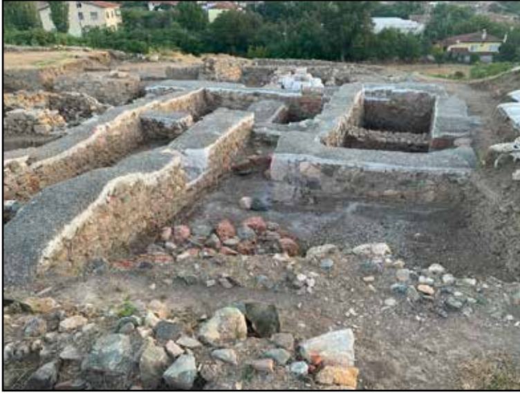
Resim 10. Roma dönemi harçlı duvarlarında koruma çalışmaları
