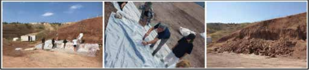
Resim 4: Kazı Alanının Kapatılması
