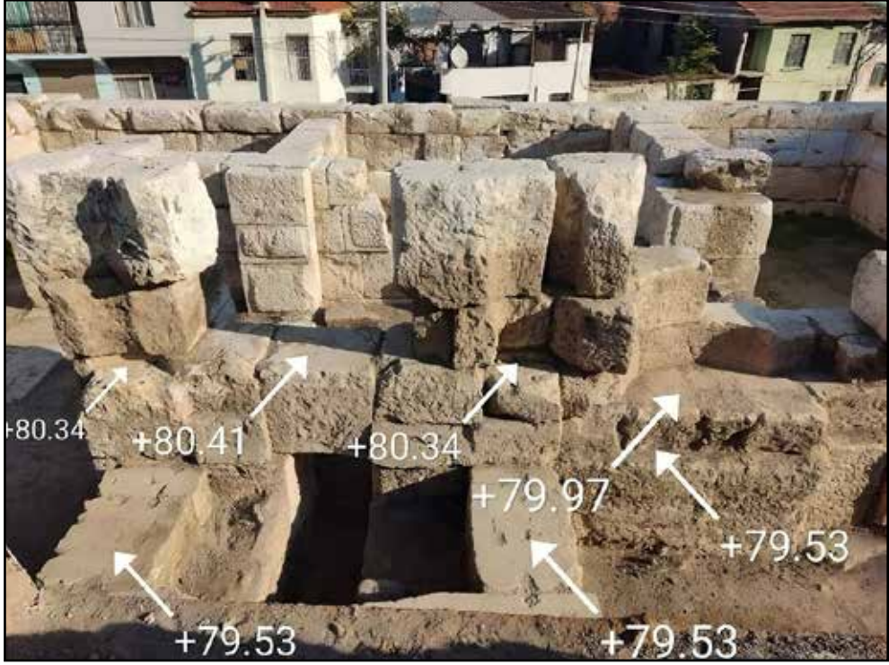
Resim 14: Sahne Binası güney cephesine ait aedicula temel blokları
