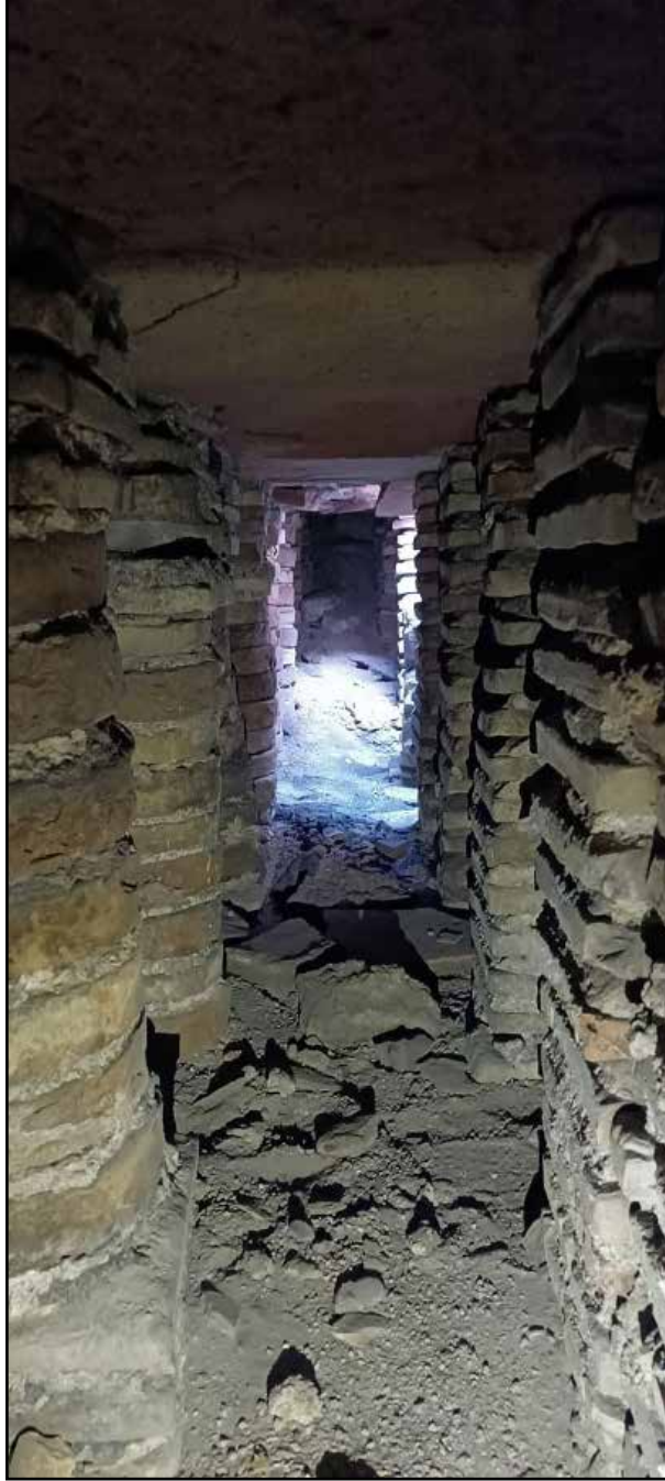
Resim 2: Terleme Odası Hypocaust sistemi.
