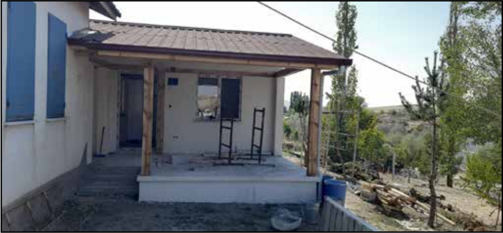
Resim 9: Yeni konservasyon laboratuvarının yapım sürecine ait genel görünüm.
