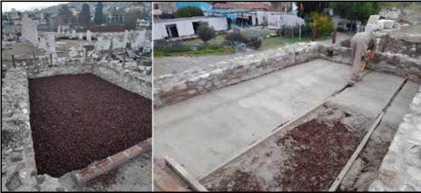
Resim 7: Çeşmeli Sarnıç izolasyon çalışmaları
