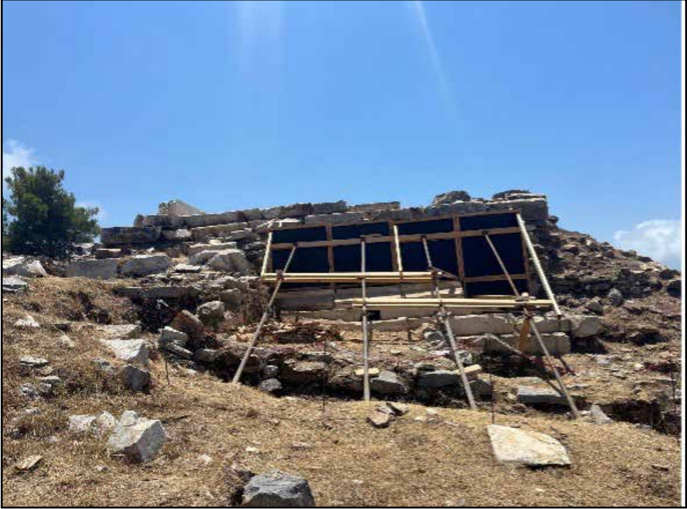
Resim 13 : Kuzeydoğu Tapınağı'nın ahşap iskelesi.
