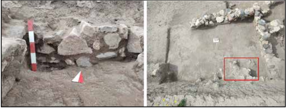
Resim 4: a. 3 No.lu Mekân kuzey duvarı. b. 3 No.lu Mekân kuzey duvarı tahribatı.
