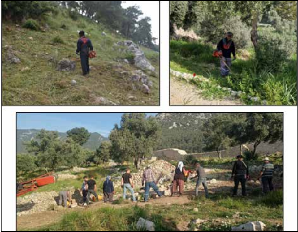
Resim 9: Güney yamaç ve Orta Çağ Kalesi iç kesimlerinde gerçekleştirilen ot ve bitki temizliği ile taş tahliye çalışmaları (İdyma Kazı Arşivi).
