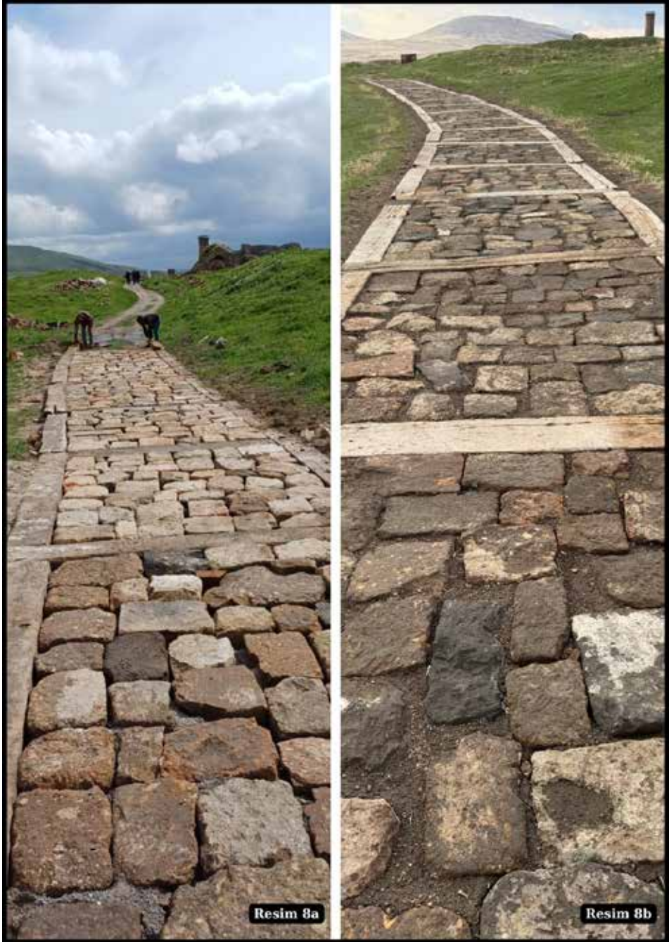
Resim 8a-b: Sur içi yürüyüş yollarının uygulama sonrası görünüşleri.
