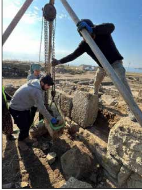
Resim 8: Basit mimari onarım.
