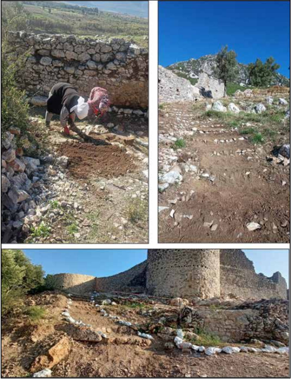
Resim 10: Kale iç kesiminde gerçekleştirilen patika yol düzenlemesi ve basamak uygulaması (İdyma Kazı Arşivi).
