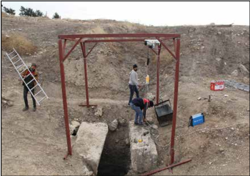
Resim 8: Kuyunun girişine kurulan elektrikli sisteminin kurulumu.
