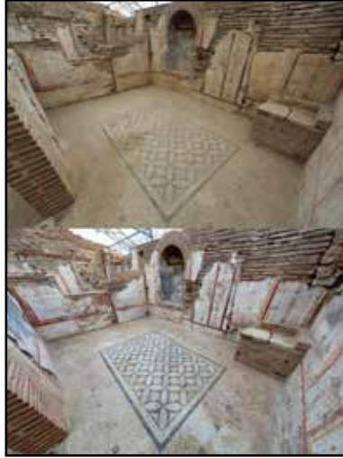
Resim 12: Yamaçevler 2 Oturma Birimi 1'in SR 10a numaralı odası. Duvar resimlerinin restorasyon ve konservasyon öncesi ve sonrası fotoğrafları (© ÖAW/ÖAI).
