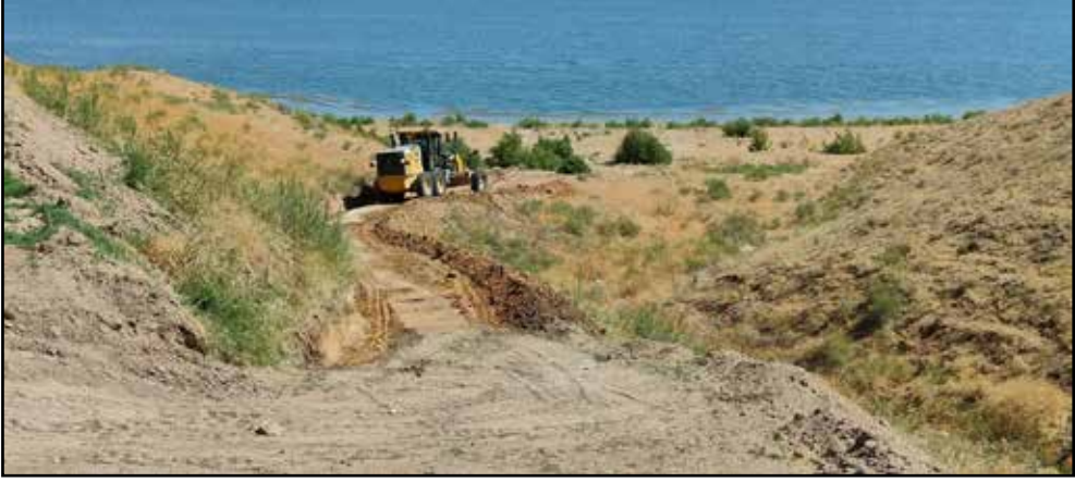
Resim 2: 1. Kazı alanına giden yolun açılması.
