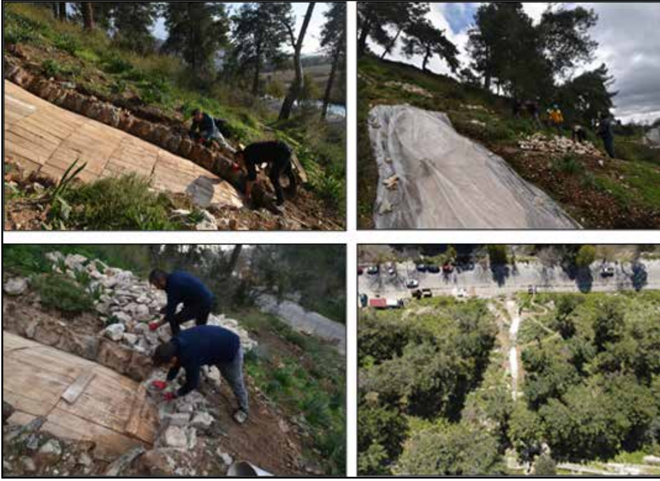
Resim 5: Dehliz içerisinde kalıp yapımı ve basit onarım amacıyla taş taşınması; devamında tonozlu tünelin örülmesi ve yapının tamamlanmış son hali (İdyma Kazı Arşivi).
