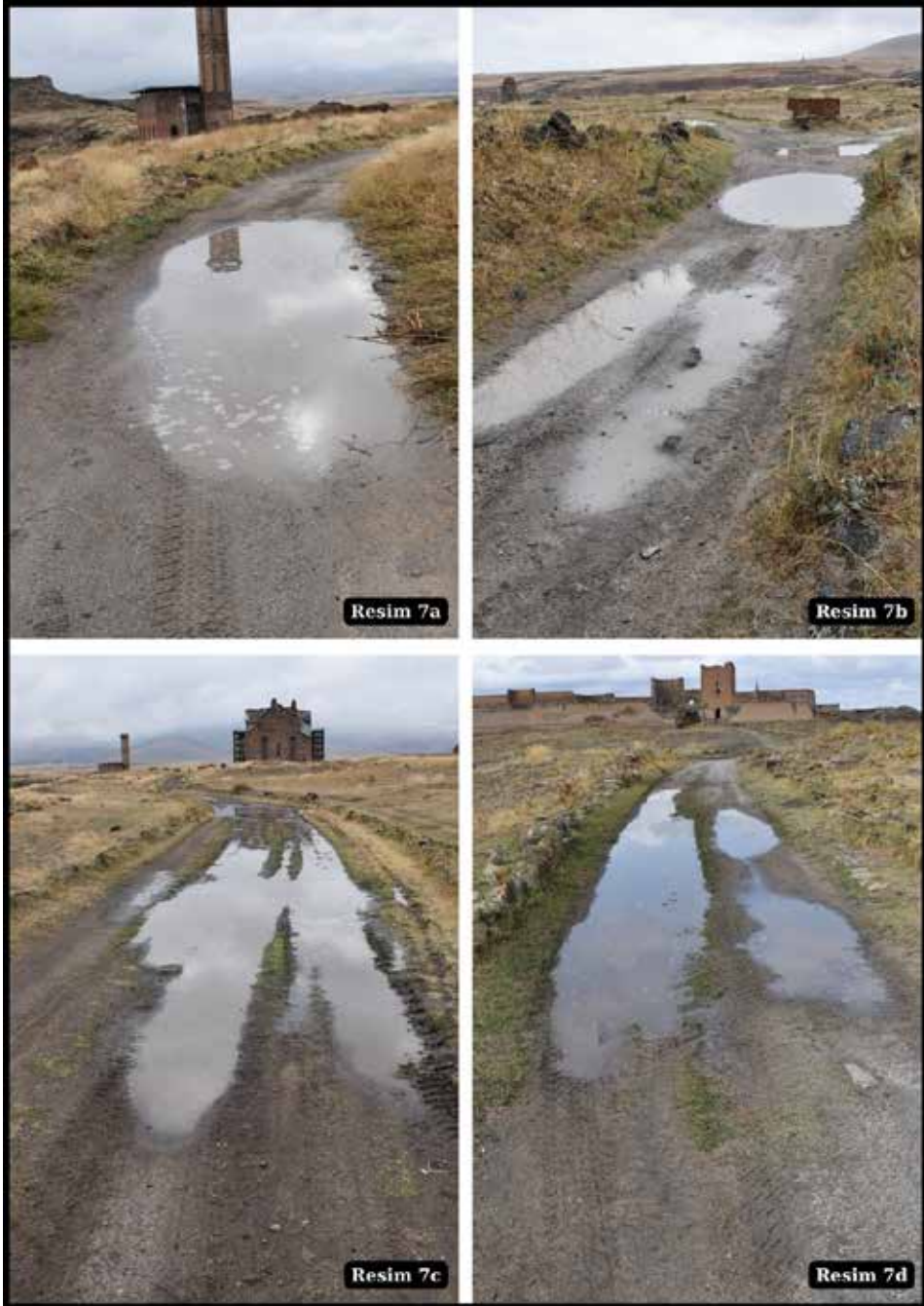
Resim 7a-b-c-d: Sur içi yürüyüş yollarının uygulama öncesi görünüşleri.
