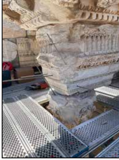
Resim 11: Celsus Kütüphanesi ön cephe üst kısmının 8. aksındaki mimari elemanlarının statik stabilizasyonu (© ÖAW/ÖAI).
