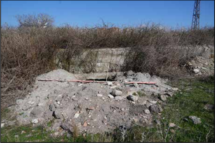
Resim 10: Üç Çeşmeler Mevkii'nin çalışma öncesi durumu.
