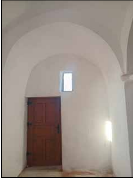
Resim 4: Uygulamalar sonrasında Türbe binasının durumu.
