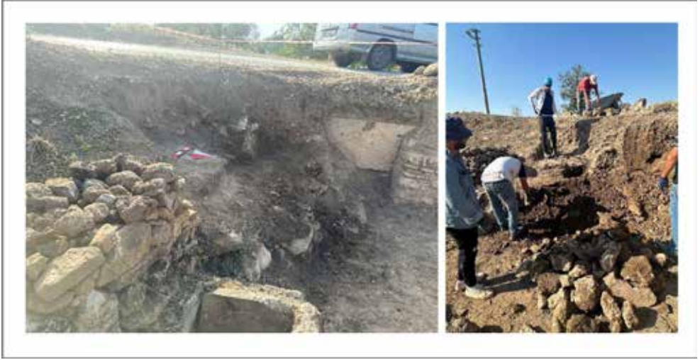
Resim 9: Büyük Kilise'nin Narteks bölümündeki ot ve moloz hafriyat temizleme çalışması.
