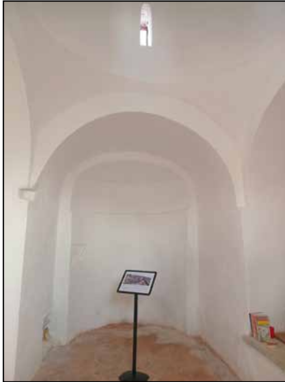
Resim 3: Uygulamalar sonrasında Türbe binasının durumu.
