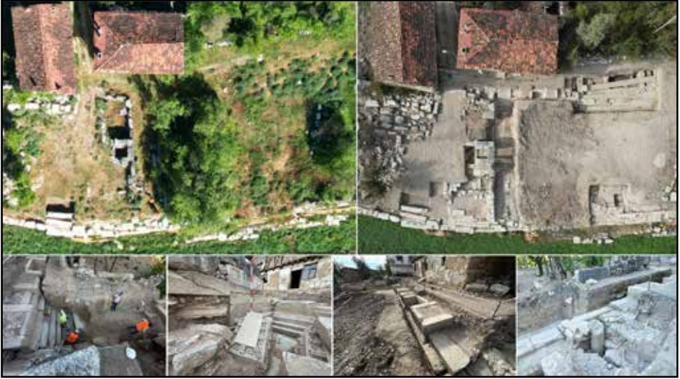
Fotoğraf 9: Podyumlu Yapı ( Aedicula Cepheli Yapı ): Çalışmalar öncesi ve sonrası görünümü.
