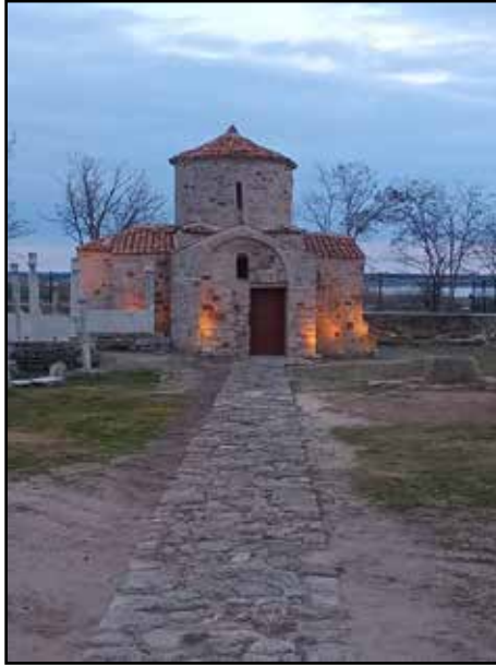
Resim 5: Uygulamalar sonrasında Türbe binasının durumu.
