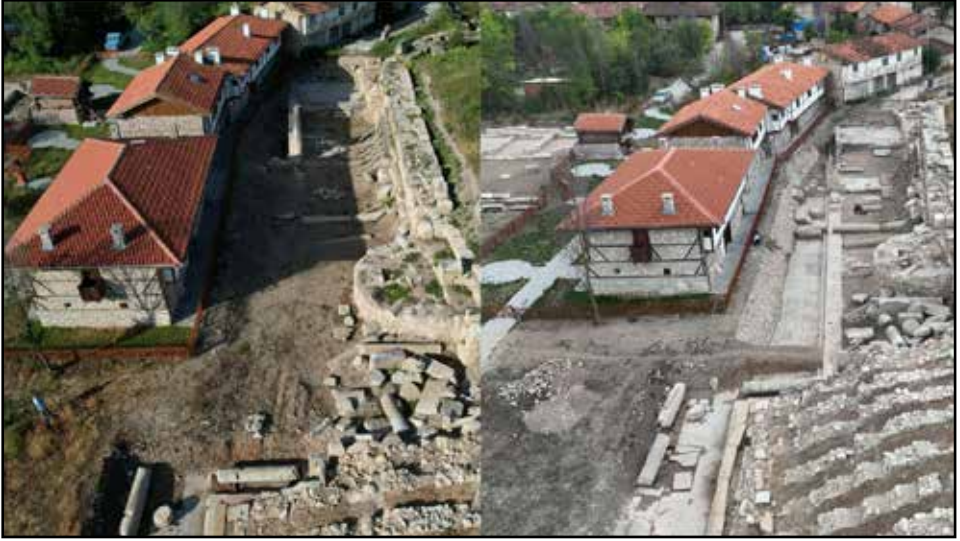
Fotoğraf 5: Agora Batı Portiko Güney Kanadı: Çalışmalar öncesi ve sonrası görünümü.
