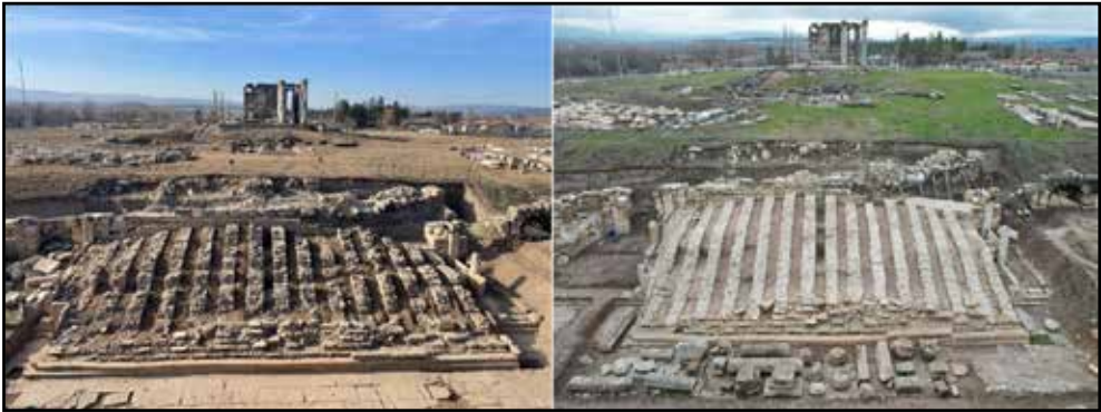
Fotoğraf 4: Zeus Tapınağı Propylonu: Koruma-onarım çalışmaları öncesi ve sonrası görünümü.
