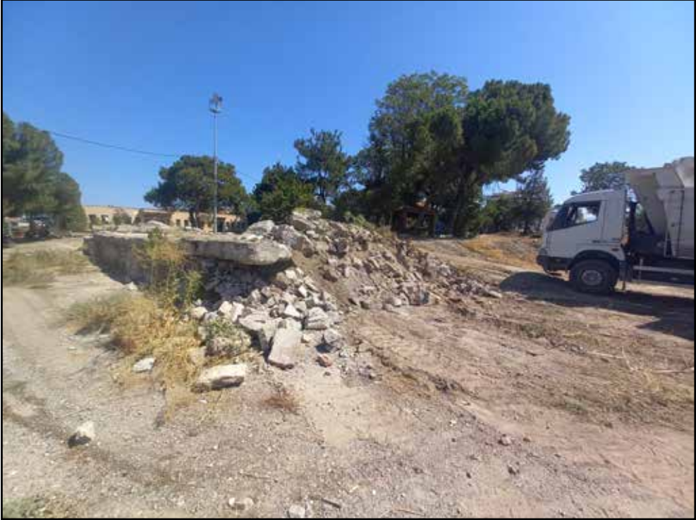
Resim 1: Akhisar Devlet Hastanesi'nden kalan fayans ve beton dolgunun kaldırılması.
