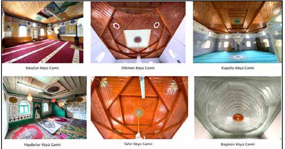
Resim 7: Beypazarı camilerinde tespit edilen döner eksenli bindirme tavan örnekleri
