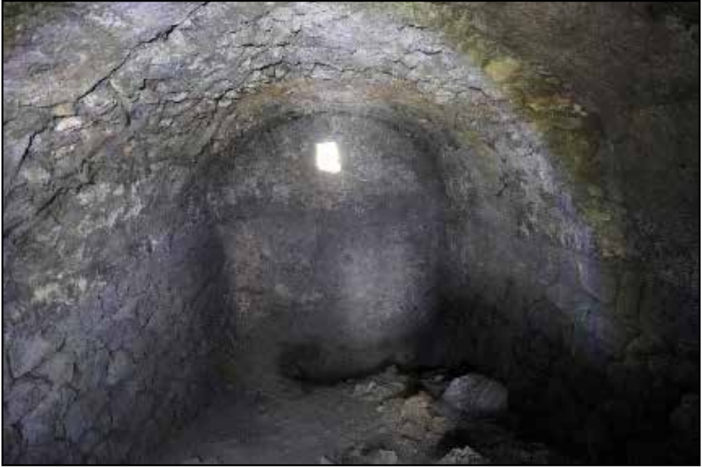
Resim 4: Hacıhamza Köyü Sinan Paşa Hamamı ve Halılar Köyü Su Sarnıcı
