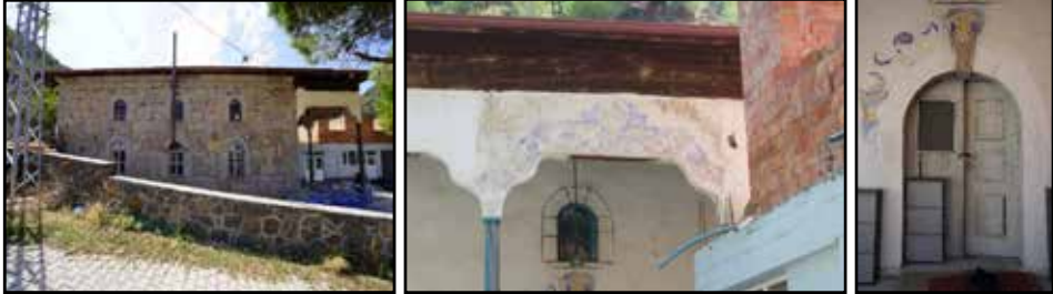
Resim 12: Dodurga, Mehmet Dede Obruk Köyü Camii
