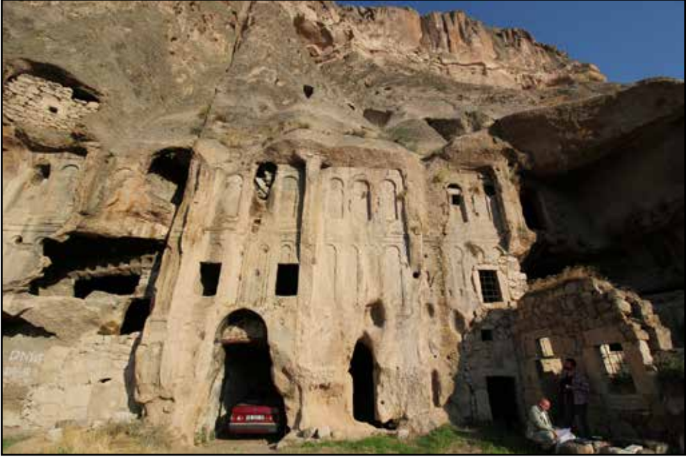
Resim 10: 5 No.lu Yapı Kompleksi, cephe düzenlemesi
