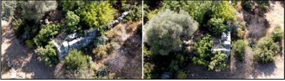
Resim 4: Alt Teras Duvarı hava fotoğrafı
