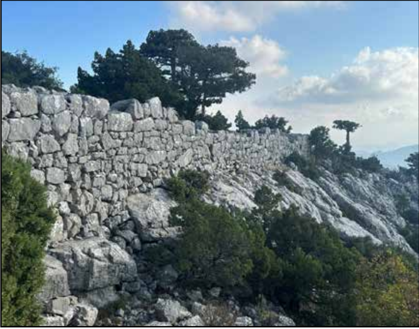
Resim 13: Dedeler Mahallesi, Muhrantepe Kalesi, Kale Duvarı
