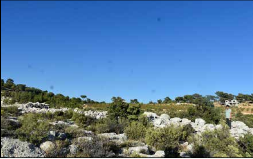
Resim 11: Çavuşlar Kalesi Duvarları Ve Burçları
