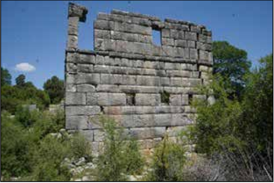
Resim 1: Vergi Binası Güneydoğu Cephe
