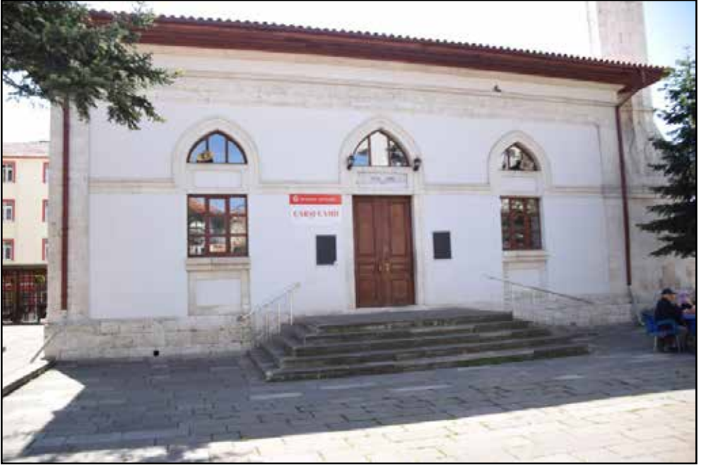
Resim 1: ÇarŐı Camii, kuzey cepheden genel görünüm
