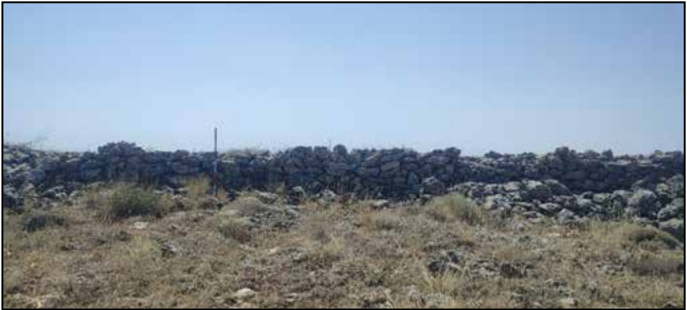
Resim 4: Onar RES Sahası Kepez Tepe Mevkii Savunma Yapısı Duvar Örgüsünden Detay
