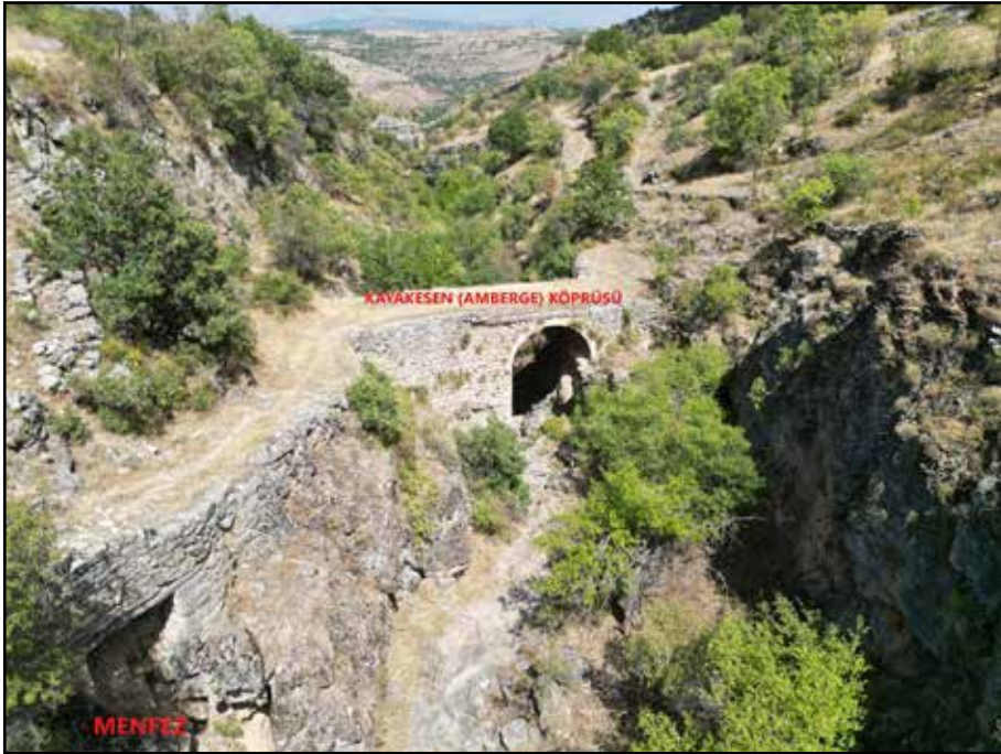
Resim 8: Kayakesen Kaldırım Köprüsü, Antik Yol ve Menfez
