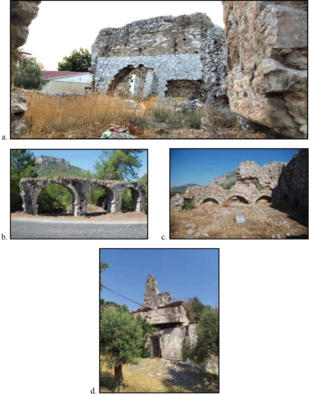
Şekil 1: Keramos Antik Kenti Anıtları (a) Roma Hamamı, (b) Su Kemerı (Aquadukt), (c) Ak Yapı ve (d) Kurşunlu Yapı (Keramos Yüzey Araştırmaları Arşivi)
