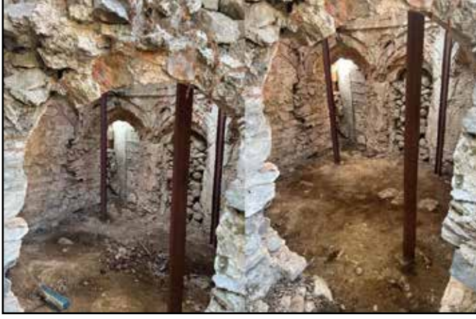
Resim 8: Osmanlı Hamamı temizlik çalışmaları
