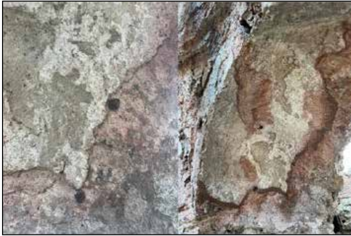
Resim 9: Osmanlı Hamamı sıvalarında bordür uygulaması
