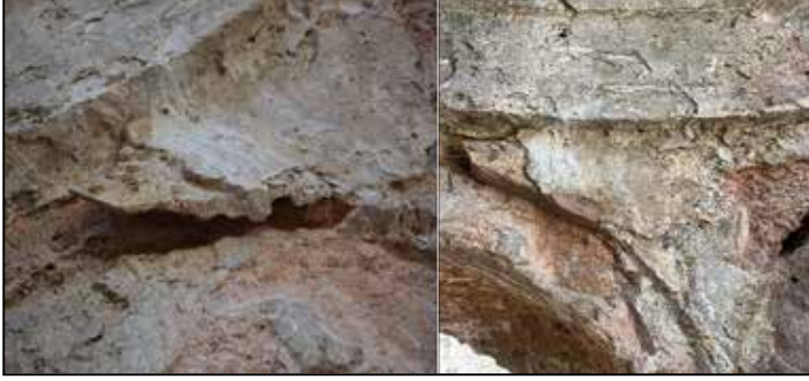
Resim 10: Osmanlı Hamamı sıva boşluklarında enjeksiyon uygulaması
