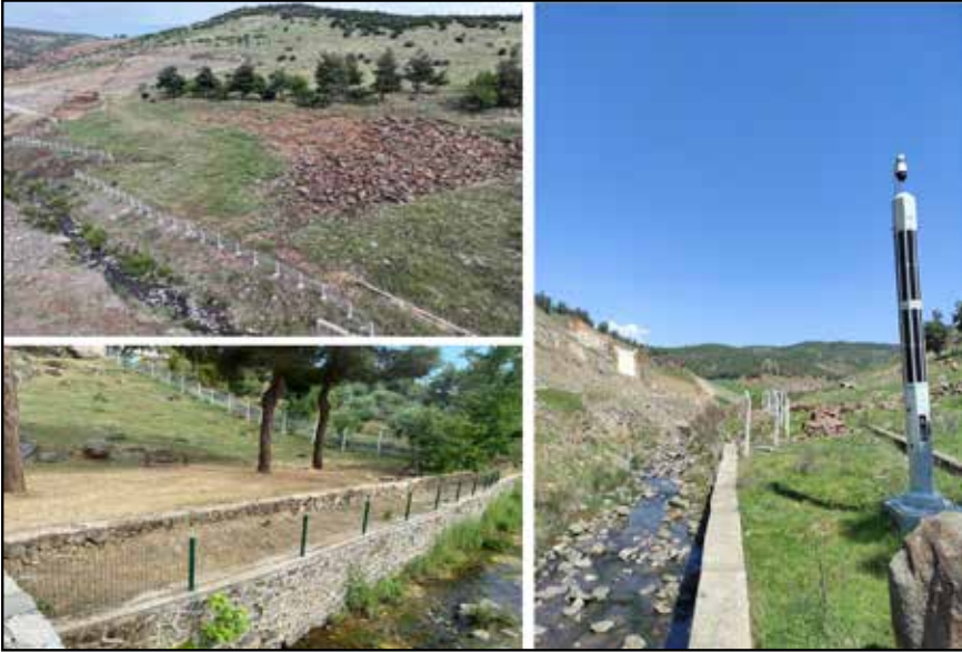
Resim 14: Çevre düzenlemesi kapsamında panel çit, tel çit ve solar güvenlik kameraları.
