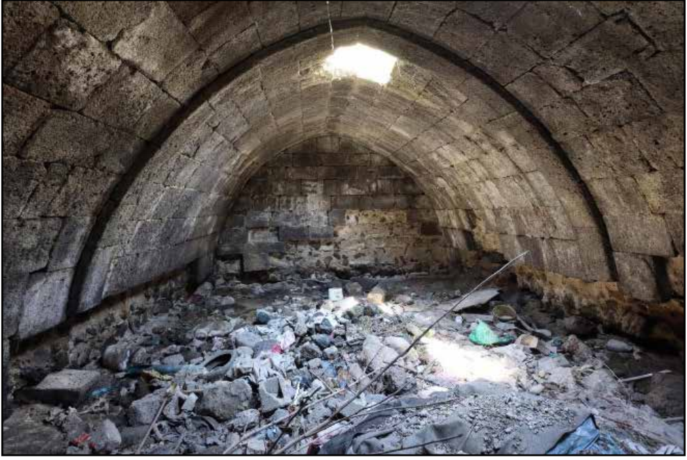
Figür 13-a): Malazgirt Kalesi Han ve Çevresinde Yapılan Temizlik ve Sondaj Çalışmaları--Temizlik Öncesi
