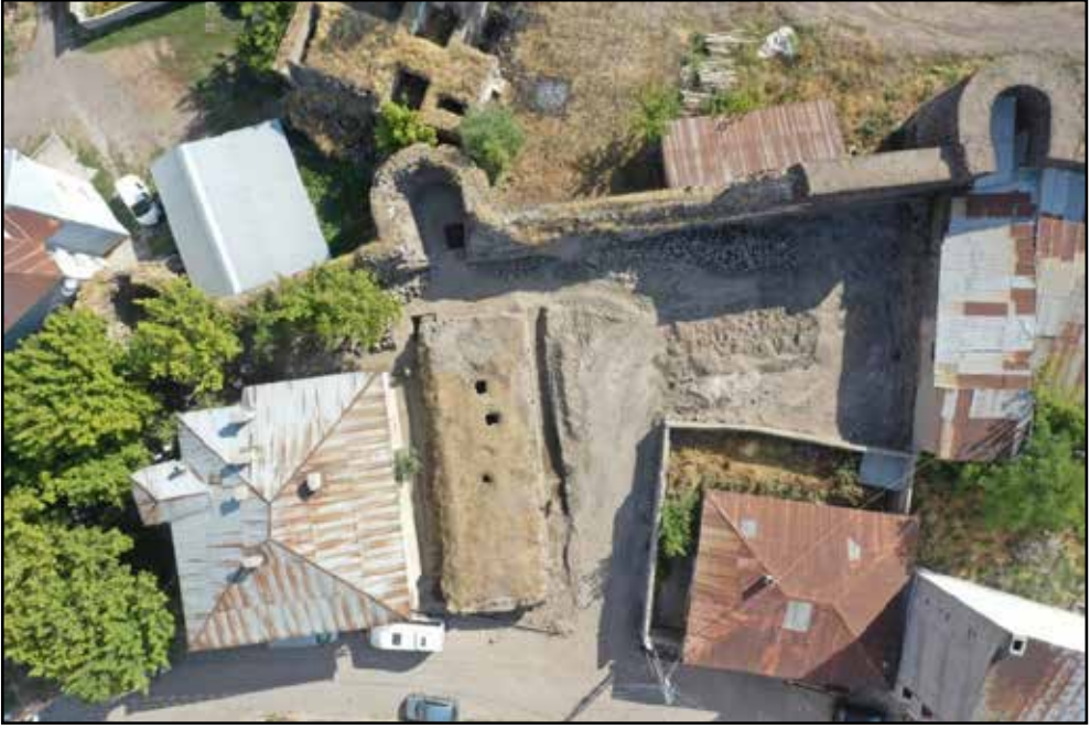
Figür 11: Han ve Çevresinde Yapılan Temizlik-Sondaj Çalışmaları'nda Belirlenen A, B, C, D Alanları
