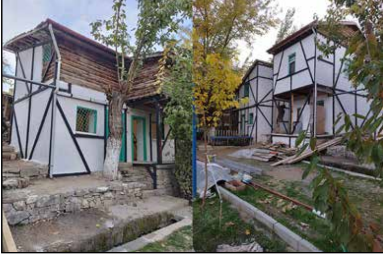
Resim 1: Deprem Sonrası Arslantepe Kazı Evi Güçlendirme Çalışmaları
