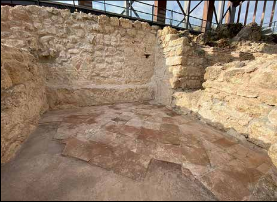
Resim 11: Geç Roma Konutu, terrakotta zemin restorasyon sonrası.
