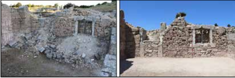
Resim 3. Hamam 2.no.lu Salon çalışmalar öncesi ve sonrası durumu
