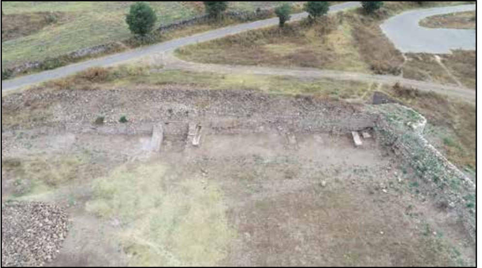
Resim 5: İç Kale-Sur Duvarı, 2023 yılsonu hava fotoğrafı.
