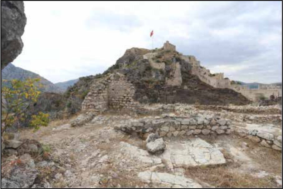
Resim. 4 : Harşena Kalesi’nin “Zaviyeli Yapı” Olarak Adlandırılan Kısımının Yangın Sonrası Görünümü
