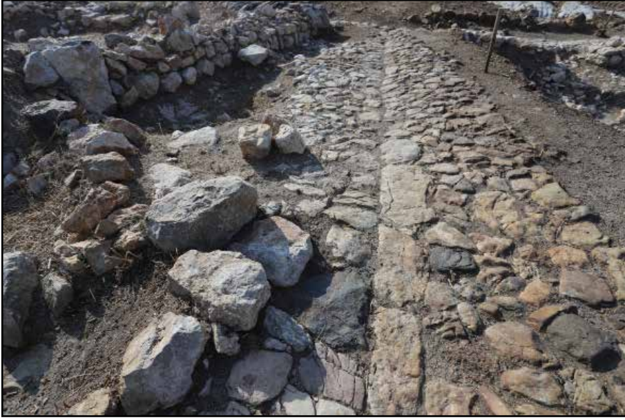
Resim. 5: Yangın Sırasında Renk Değişimine Uğrayan Sokak Döşeme Taşları
