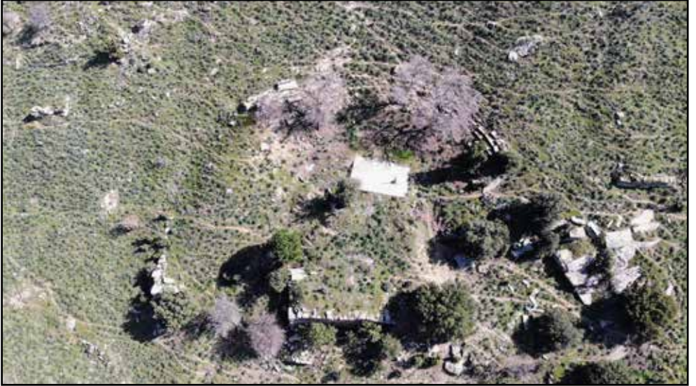
Resim 9: Tiyatro binası, havadan görünüm.
