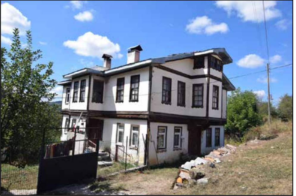
Resim 8: Molla Recep Konağı, ahşap karkas yapılı ve bağdadi sıvalı cephe, XX. yy. başları.
