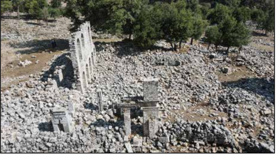
Resim 13: Belören köyü Alakilise Mevkii, kilisenin batıdan genel görünümü.
