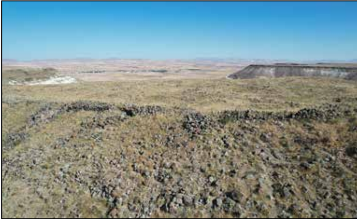
Resim 4: Yukarı kale güneybatı duvarı kalıntıları.
