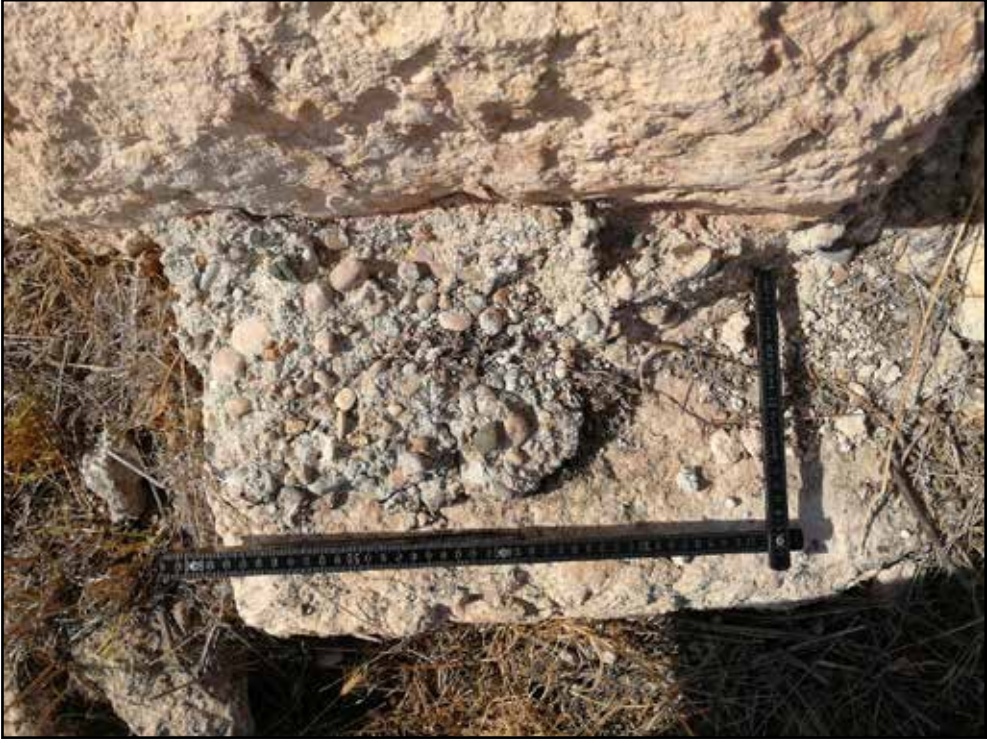
Resim 3: İki sıra korunmuş bir duvarın irice dere taşı agregalarla hazırlanmış kireç esaslı derz harcı.
