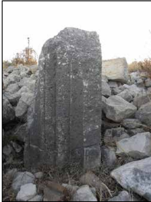
Resim 8: Bir yapının kapısına ait in situ söve.
