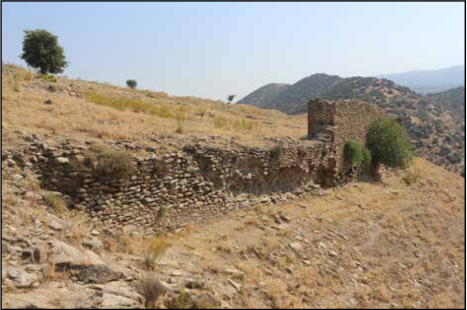
Resim 13. Bizans Kalesi'ne ait duvar ve korunma durumu.
