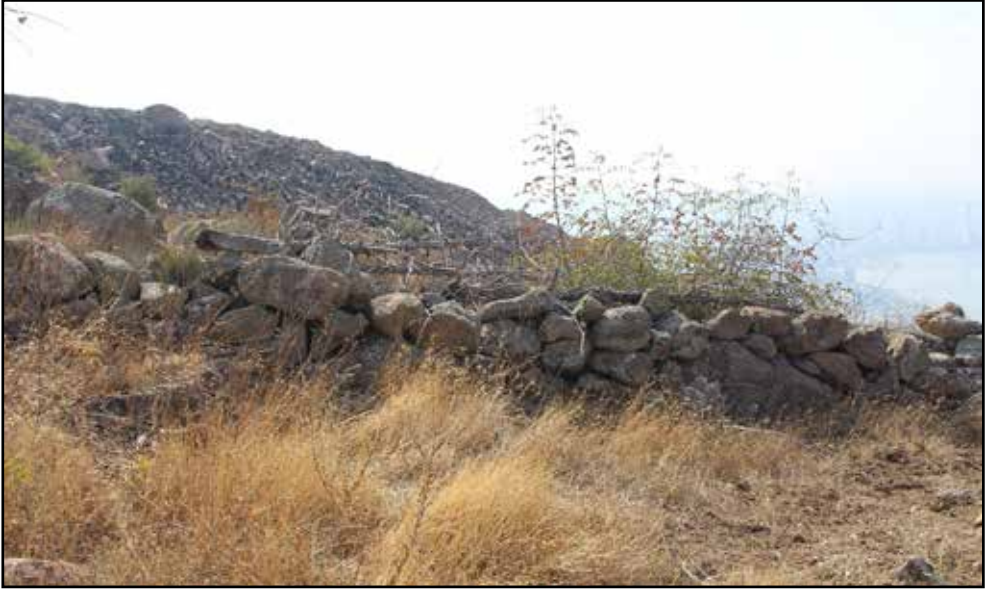
Resim 4: Küçükkaletepe geç duvar yapısı/istinat duvarı.
