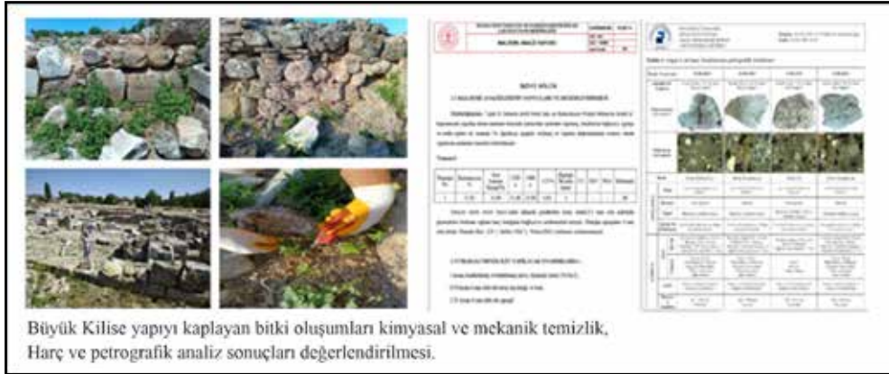
Resim 10: Büyük Kilise yapısını kaplayan bitki oluşumları kimyasal ve mekanik temizlik, harç ve petrografik analiz sonuçları değerlendirilmesi.
