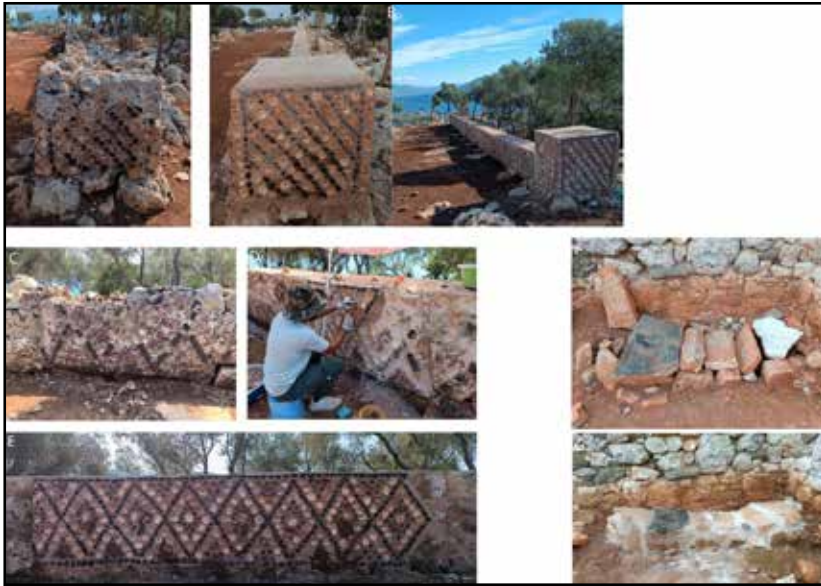
Resim 13: A) Orata Adası, tören yolu restorasyon öncesi. B) Orata Adası, tören yolu restorasyon sonrası. C) Orata Adası, tören yolu restorasyon öncesi. D) Orata Adası, tören yolu, çalışma anı. E) Orata Adası, tören yolu restorasyon sonrası. F) Kıstak Kilise, mezar sağlamlaştırma öncesi. G) Kıstak Kilise, mezar sağlamlaştırma sonrası (Kedrai kazı arşivi).
