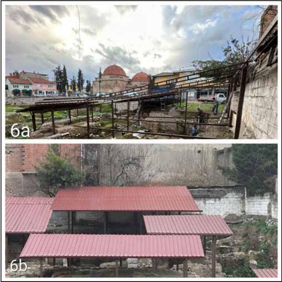
Resim 6a: İÇFK 2023 Kazı Alanı, Sundurma yapımı.
