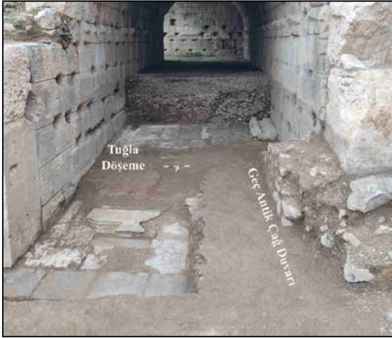
Resim 5: Vomitorium girişinde yer alan tuğla döşeme ve Geç Antik Çağ duvarı.
