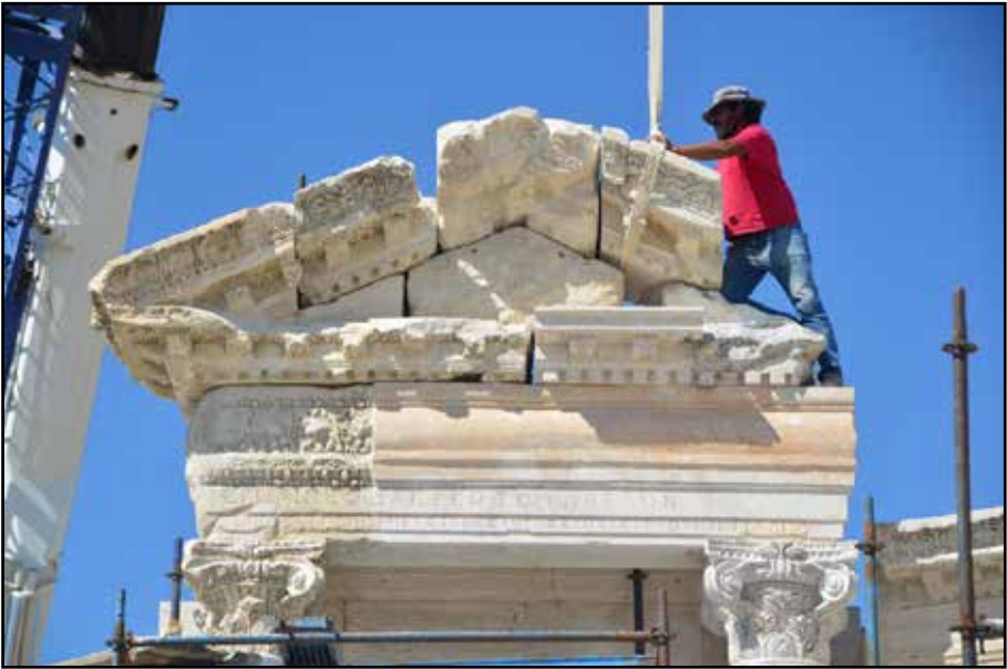
Resim 10: Traian Nymphaeumu'nda ana alınlıkta yapılan restorasyon çalışmaları.
