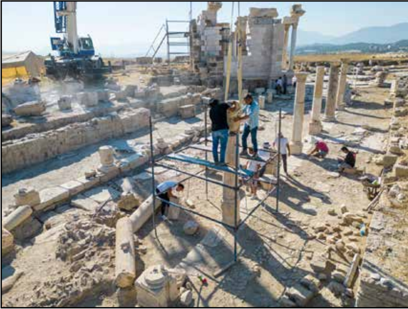
Resim 4: Batı Caddesi'nde yapılan restorasyon çalışmaları.
