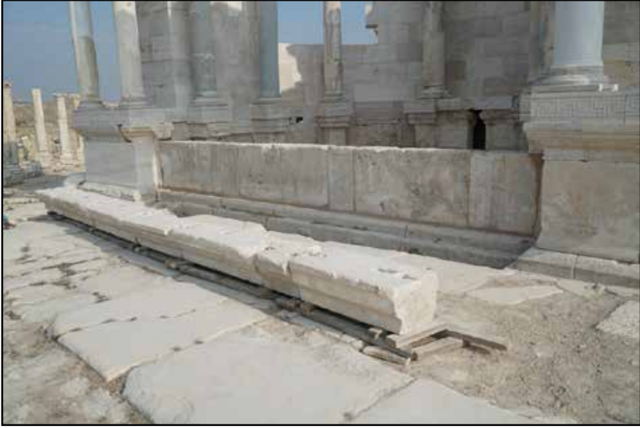
Resim 7: Nymphaeum ana havuz parapet lerinde yapılan restorasyon çalışmaları.
