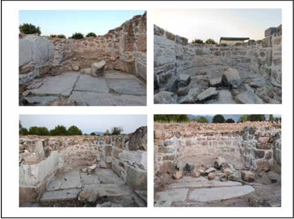
Resim 13: Küçük Kilise duvarları güçlendirme, derz dolgu ve capping işlemi öncesi ve sonrası.
