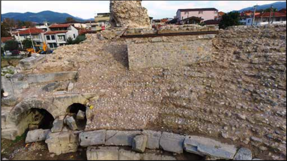
Resim 3: Cavea Kilisesi altına yapılan istinat duvarı.
