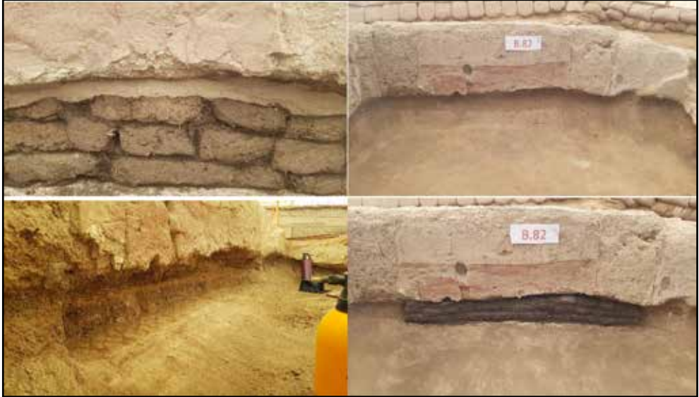
Resim 11: Bina 82'nin orijinal duvar boyalı, sıvalı duvarında uygulama öncesi görünümü Bina 82'nin uygulama sonrası görünümü.
