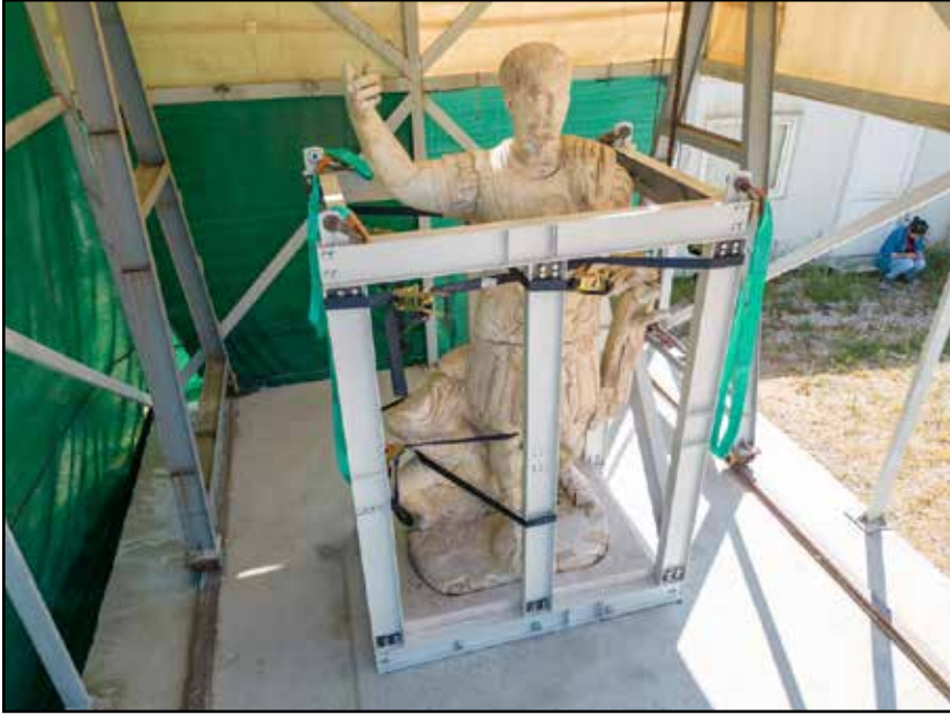
Resim 11: Traian heykel grubu için çelik asansör kabin yapılarak alana taşınması.
