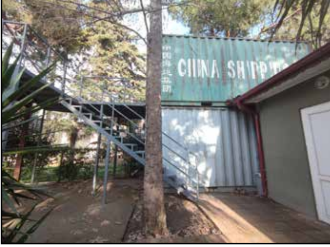
Resim 7: İÇFK 2023 Yeni Konteyner Depo ve ona ulaşmak için yapılan merdiven ile sahanlık.
