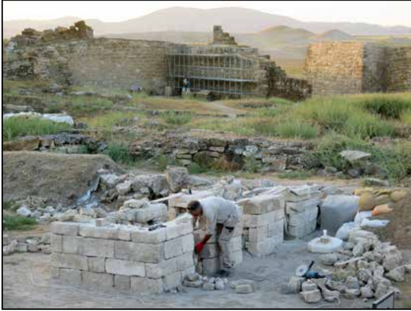
Resim 3: Megaron 3'ün hasarlı duvarlarının çevresindeki yeni taş kaplama, üstte İç Kale'nin Doğu Kapısı, güneydoğuya bakış. Fotoğraf: Elisa Del Bono.
