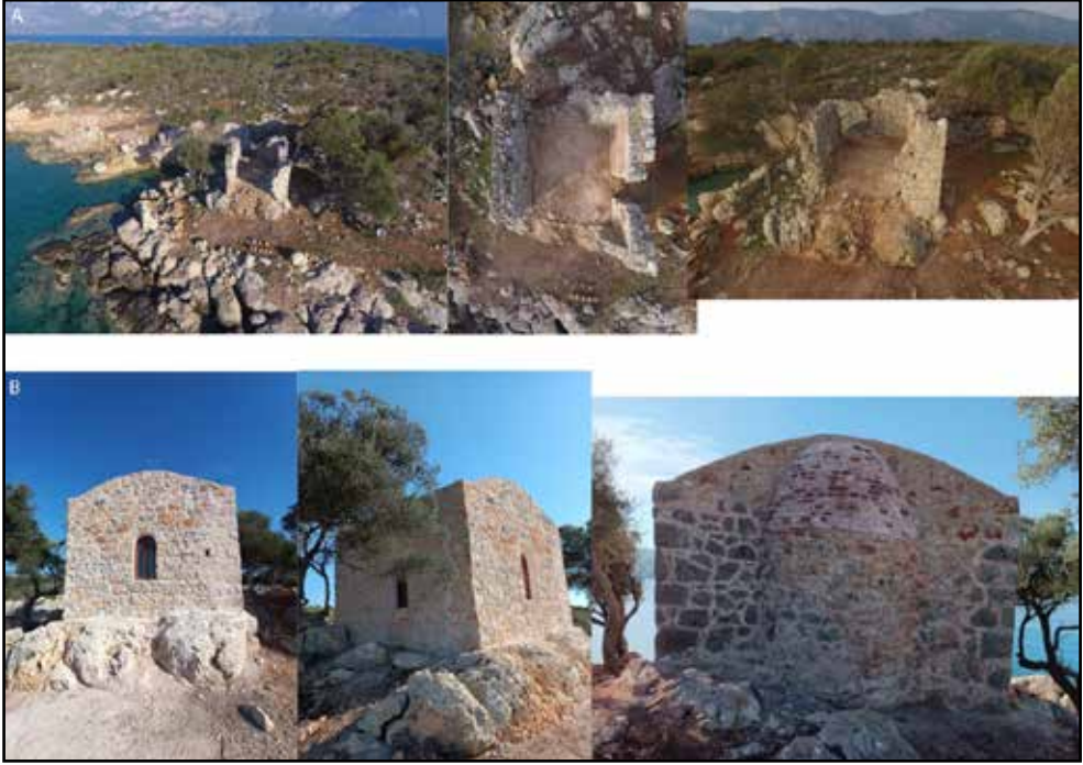
Resim 14: A) Orata Adası, Apsisli Yapı , restorasyon öncesi. B) Orata Adası, Apsisli Yapı , restorasyon sonrası (Kedrai kazı arşivi).
