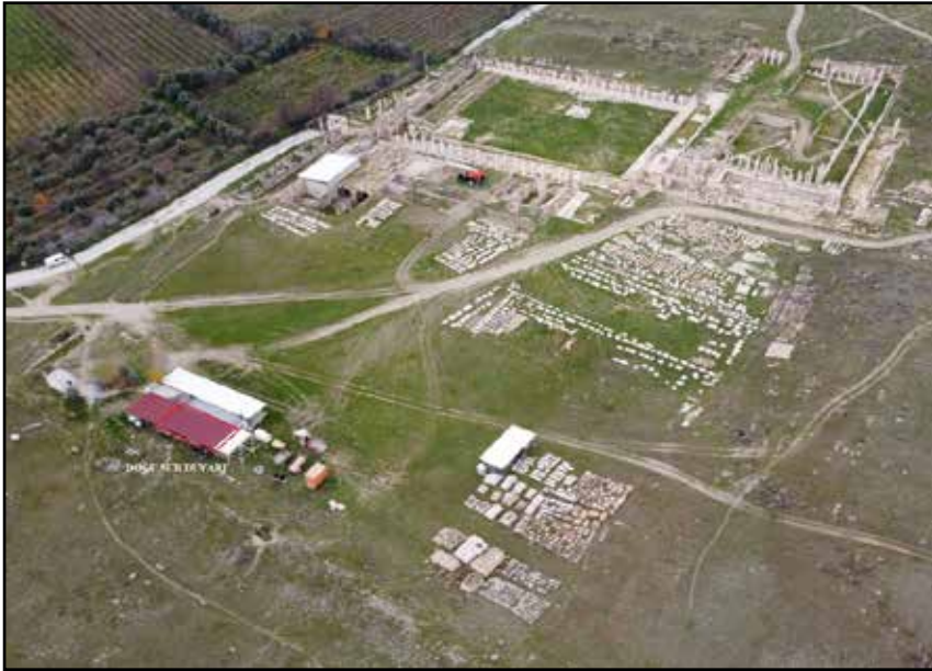
Resim 4: Doğu Sur Duvarı konumu.
