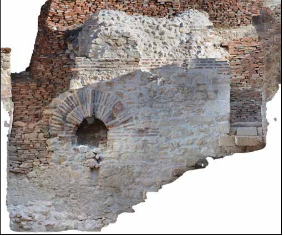
Resim 15: Hamam-Gymnasium, Merkezî Şaft, Kuzey iç duvarı – müdahale sonrası.
