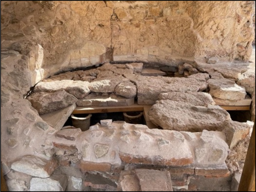
Resim 14. Suspensurayı taşıyan ahşap iskelet.
