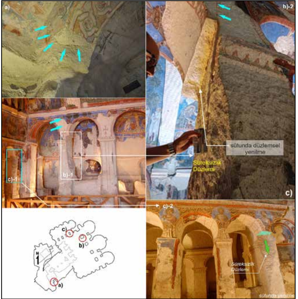
Şekil 10. Tokalı Kilise’de süreksizlik kontrollü duraysızlıklar
