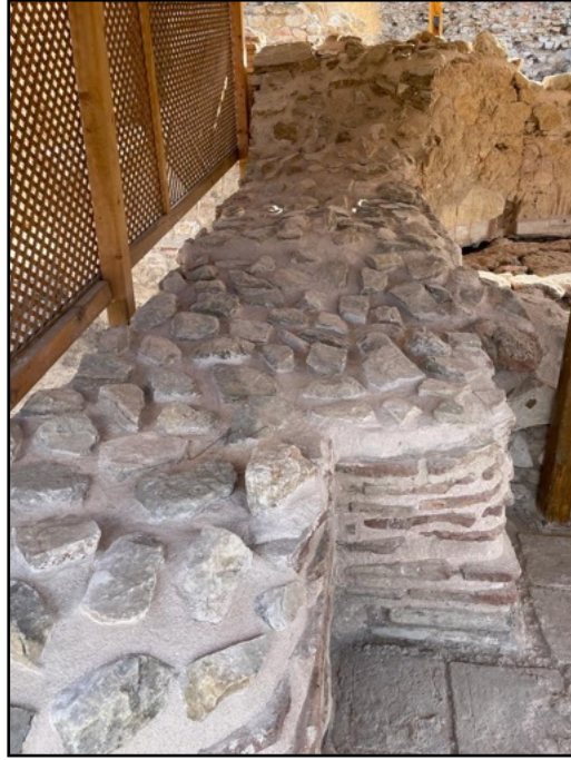
Resim 15. Lacanicum etrafındaki duvarlara uygulanan capping uygulaması örneği
