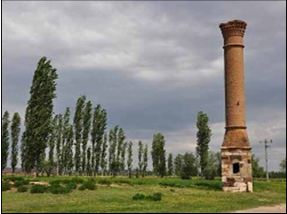
Resim 1. Dişli Beldesi Ermenek Mevkiinde yer alan Kırık Minare. Beylikler Dönemi'nde inşa edilen Ermenek Hisarı Camii'ne ait olup depremde şerefe ve külahını kaybetmiştir (Dabanlı, 2022).
