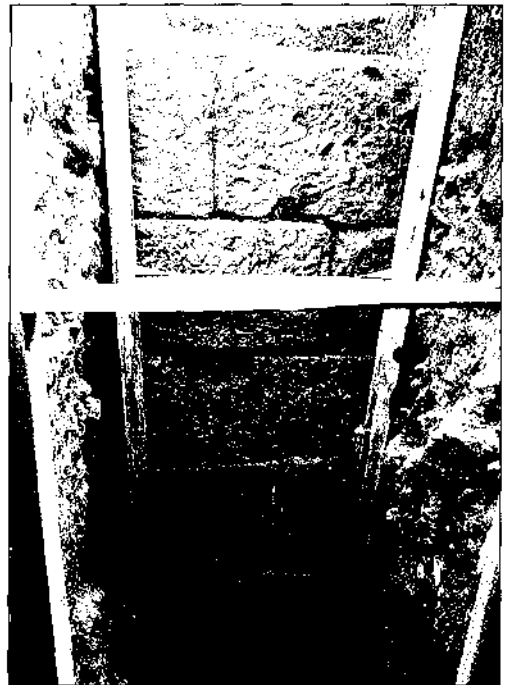
Abb. 8: Gebäude 1, Ostwand-9 Quaderlagen
