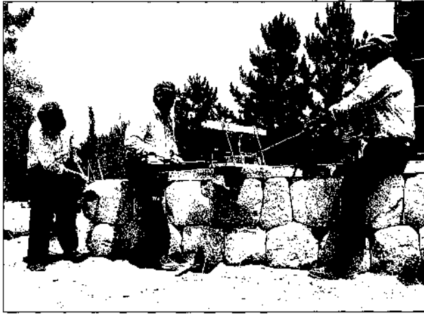
Resim 11: Çorum Müzesi için hazırlanan Hitit yapım tarzında duvar. Zivana delikleri delinirken
