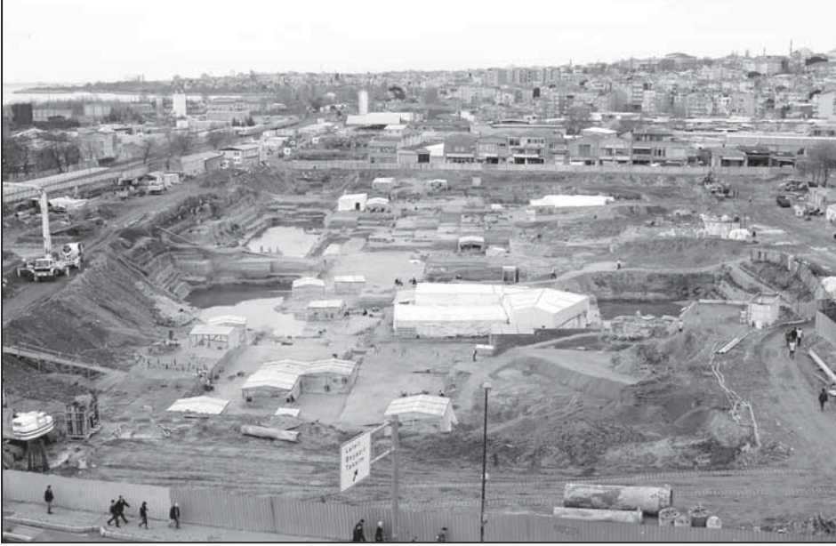
Resim 1: Yenikapı Metro ve Marmaray kazı alanının görünüşü.
