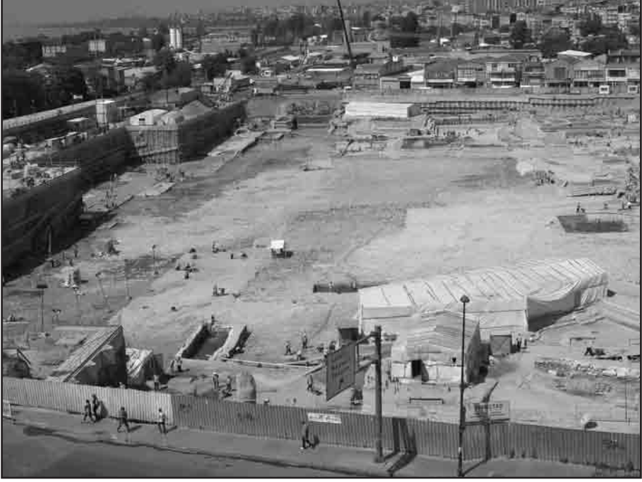
Resim 1: Yenikapı Metro ve Marmaray kazı alanı
