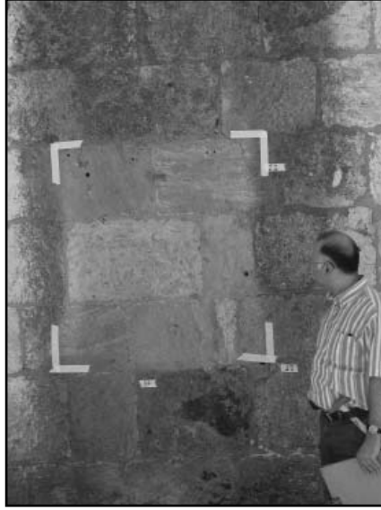
Resim 8: Pallas Sokullu Külliyesi, mikrokumlama ile temizlik denemeleri sonucu
