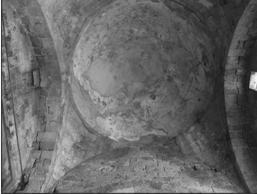
Resim 4: Pallas Sokullu Külliyesi, arasta kısmı dua kubbesi
