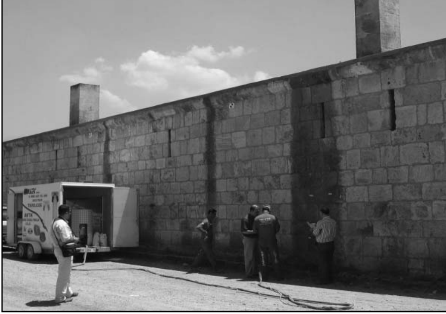
Resim 7: Pallas Sokullu Külliyesi, kervansaray kuzey duvarı, mikrokumlama ile temizlik denemeleri
