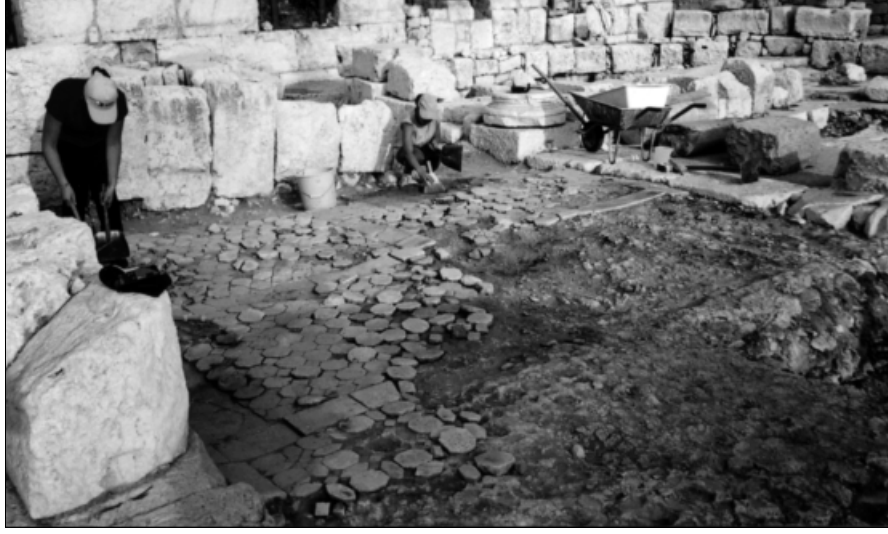
Resim 1: Onarım öncesi opus sectile tabanı
