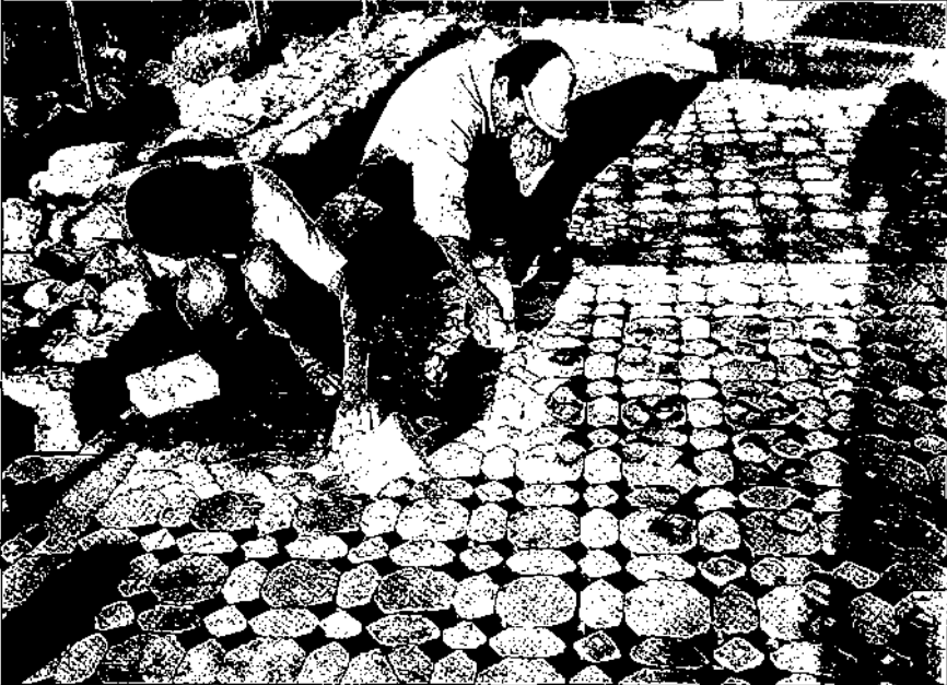
Resim 13: Boşlukların harçla doldurulması
