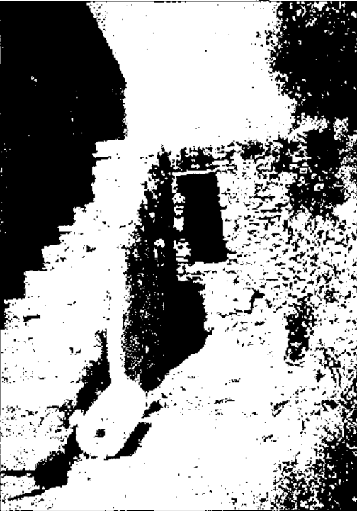
Resim 4: Belen Mahallesi'nde dam düzlemek amacıyla loğ olarak kullanılan kırık mermer sütun (2001)
