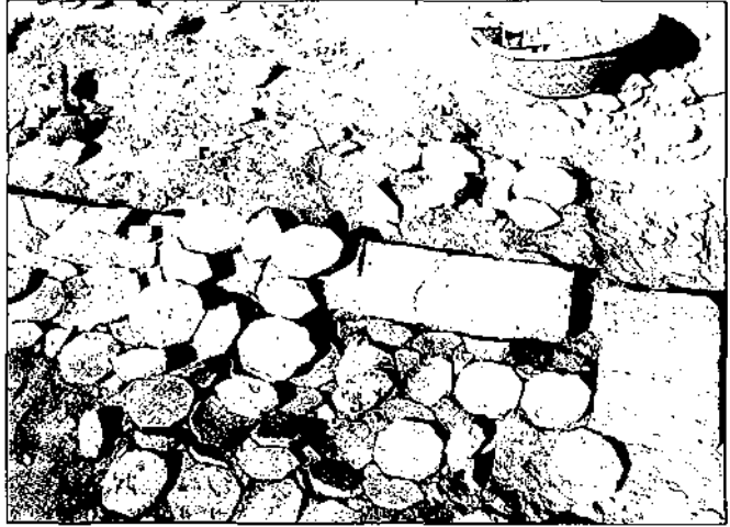
Resim 5: Taban harcının bağlayıcı özelliğini yitirmiş olması
