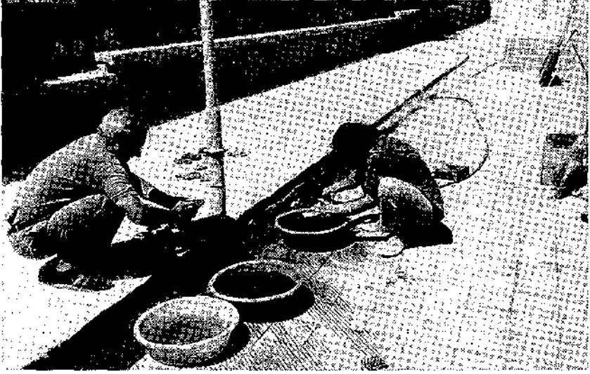
Resim: 1- Üst yüzey kir tabakasının fırça kullanılarak çıkartılması.
