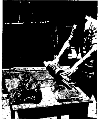
Resim : 13 — Kemer onarım çalışmaları ve onarımdan sonra arka kısmın görünümü (2) a. Araldit, cam elyafı karışımından yapılmış çubuk b. Açılmış delik c. Onarılan arka duvar d. Onarılacak belirgin duruma getirilen arka kısım
