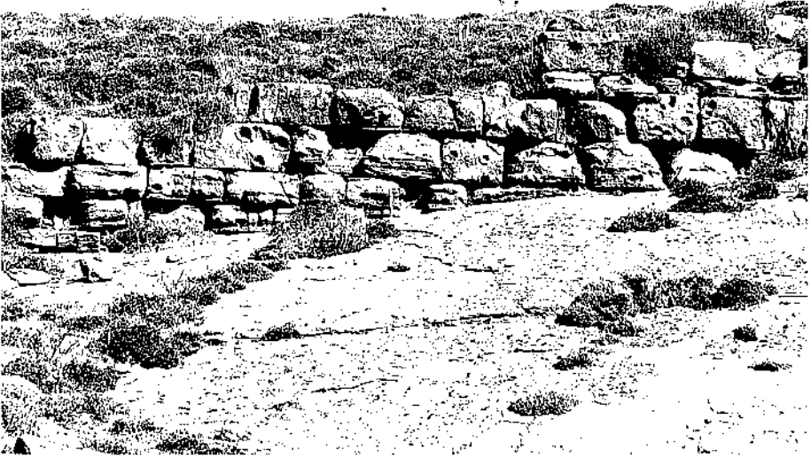
Fig.1: Kaleköy, ancient city wall, seen from east Resim 1: Kaleköy, antik sur duvarının doğudan bir görünüşü
