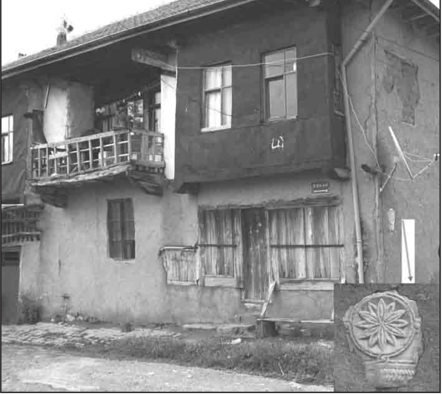
Resim 13: Yassıören. Kerpiç yapı
