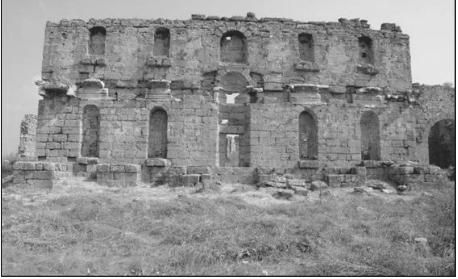
Resim 3: Agoranın kuzeyindeki çeşme binası
