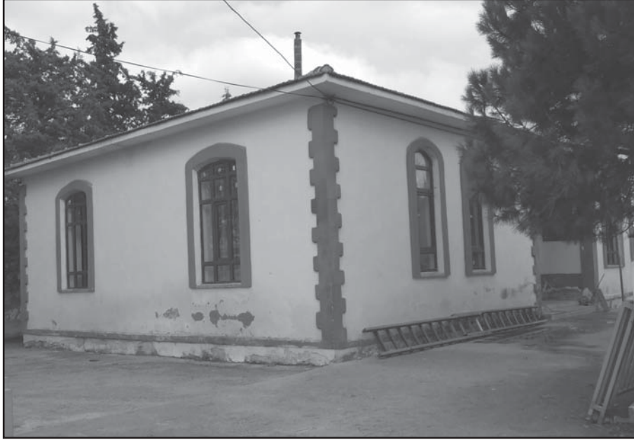
Resim 5: Kuzköy’de ilkokul binası
