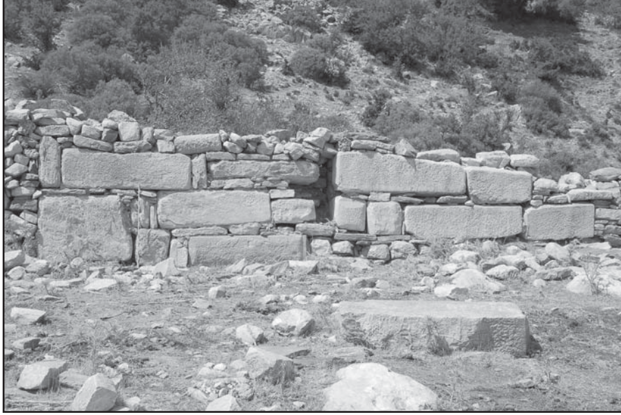
Abb. 3: MYK 293. Spätosmanischer Spolienbau aus wiederverwendeten Polsterquadern eines hellenistischen Grabbaus, Südfront von Süden
