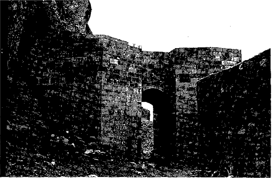
Resim 9: Harput İç Kale ikinci giriş kapısı
