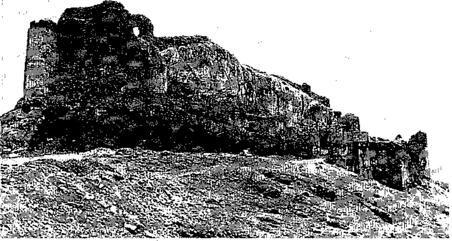
Resim 2: Harput İç Kale kuzey sur duvarları
