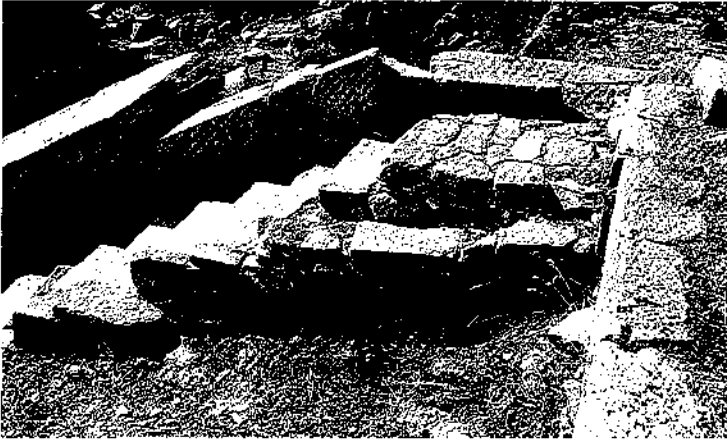
Abb. 14 : Priene. Reparierter Weg ins Theater über die Treppe am Westanalemma (Photo J. Misiakiewicz).
