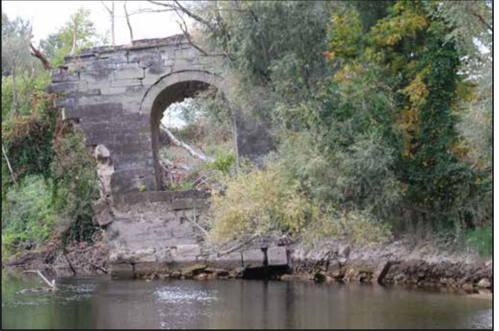
Resim 6: Taşköprü - Rebas Köprüsü.
