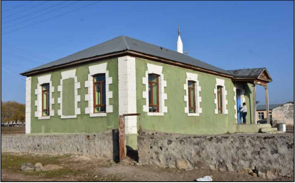
Resim 12: Arpaçay, Meydancık Köyü okul binası
