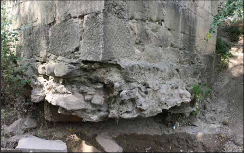
Resim 7: Taşköprü - Rebas Köprüsü.
