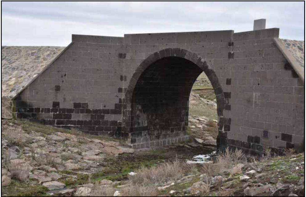
Resim 7: Arpaçay, Gediksatılmış Köyü köprüsü
