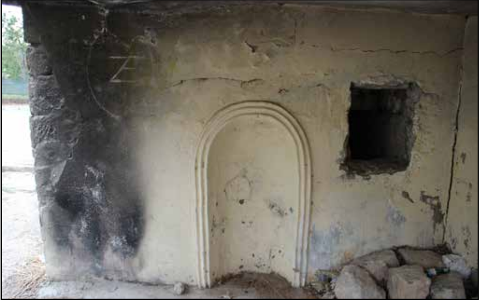
Resim 1b: Gümüşler Köylü Çeşmesi kuzey ve güney cephelerinden görünüm.
