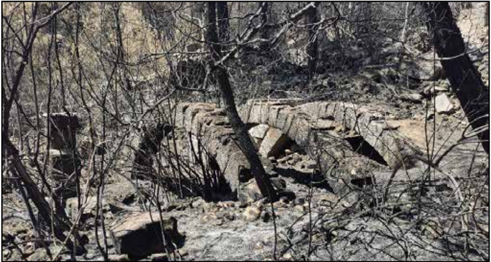
Resim 4: Agoranın kuzeyindeki su yapısının yangın sonrası görünümü.
