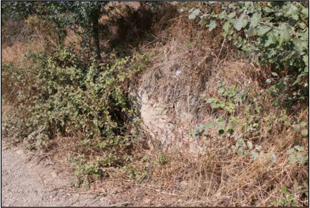
Resim 10: Moedo Orientis Köprüsü'nün karadakai ayak kalıntısı.
