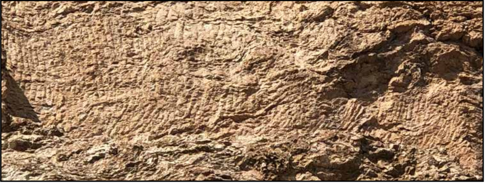
Resim 4: Sarıkaya Taş Ocağı, kuzey duvarı. Taş çıkartma izleri.
