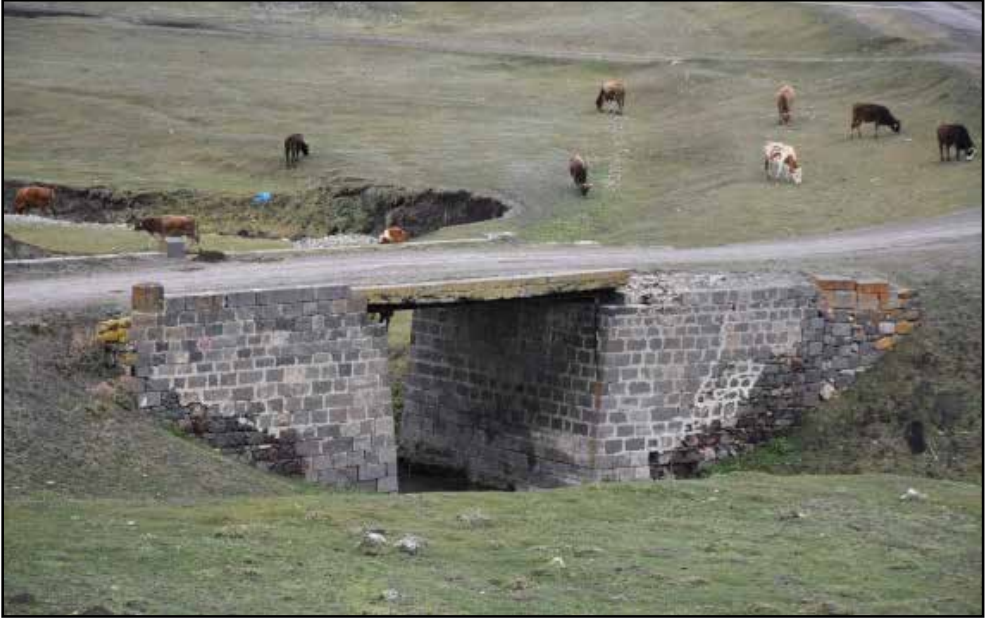
Resim 14: Susuz İncesu Köyü Köprüsü
