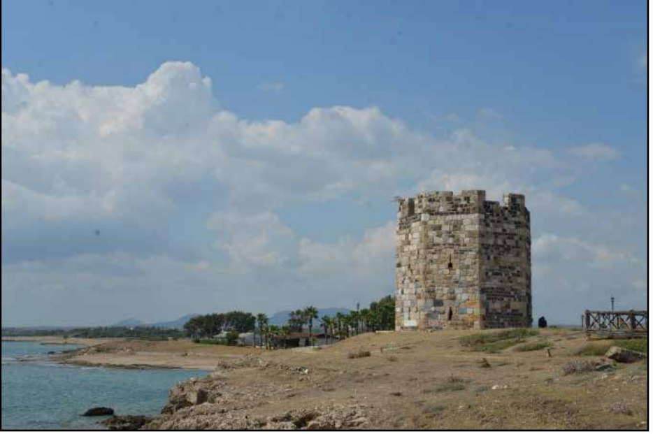
Resim-3: Süleyman Kulesi genel görünüm.
