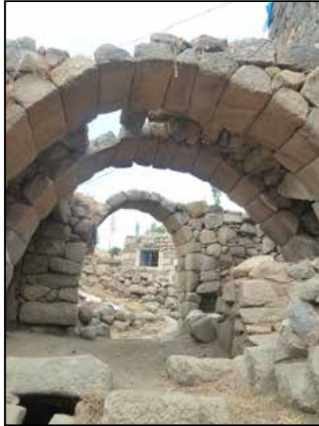
Resim 3: Murtaza köyünün geleneksel yapı tekniği olan tonoz sistemi ile inşa edilmiş mimari yapıları.
