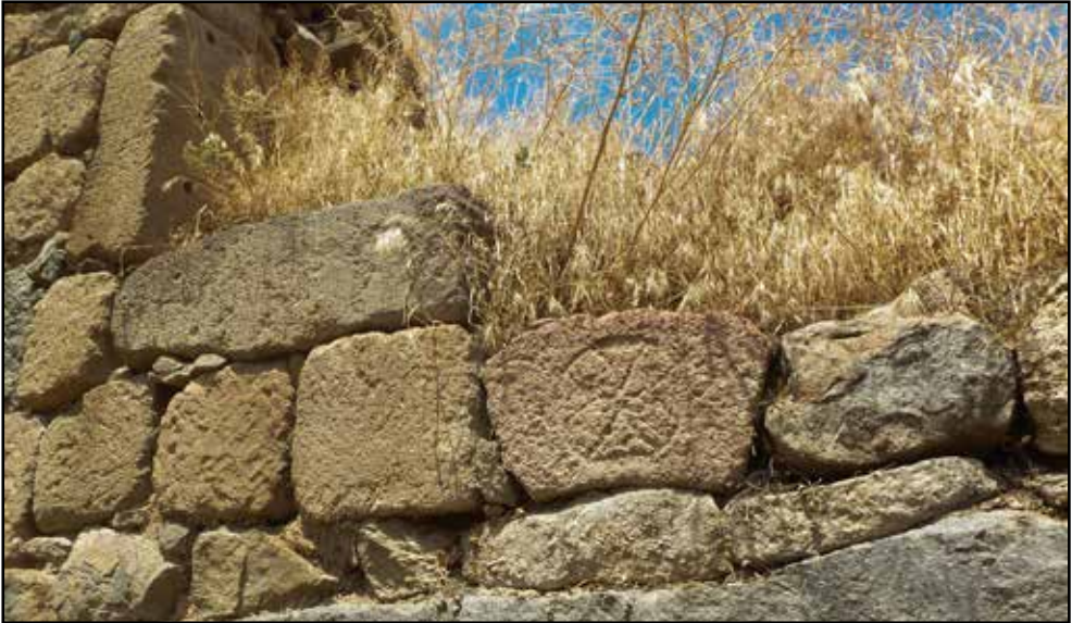
Resim 7: Murtaza köyü yerleşmesindeki bir yapının duvar örgüsünde kullanılan haç tasvirli devşirme bir yapı malzemesi.
