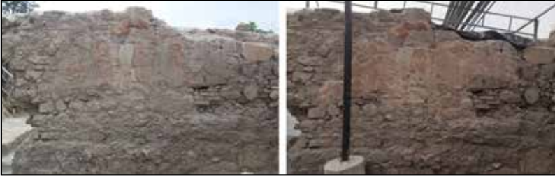
Resim 14: B2 Mekânı Güney Duvarı Konservasyon Öncesi ve Sonrası.
