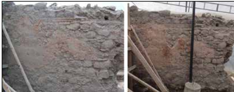
Resim 15: B2 Mekânı Güney Duvarı Konservasyon Öncesi ve Sonrası.
