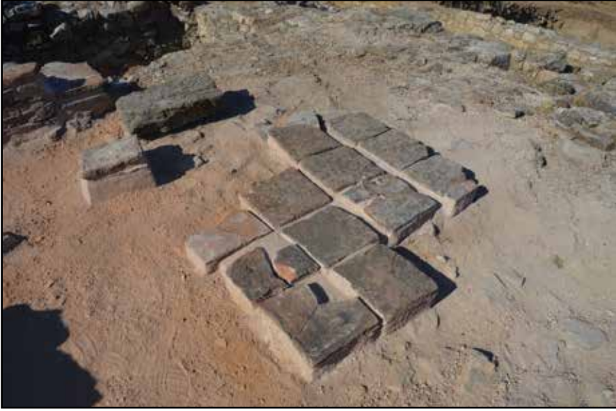
Resim 7: Pişmiş Toprak Yer Döşemesi Restorasyon Sonrası Durumu (Parion Kazı Arşivi).
