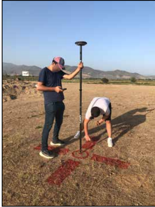
Resim 2: Arazide Yer Kontrol Noktalarının Tesis Edilmesi (Çine-Tepecik Kazı Arşivi)
