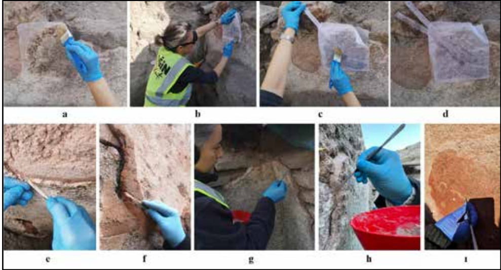
Resim 4: Geçici Sağlamaştırma ve Bordür Harcı Uygulamaları.
