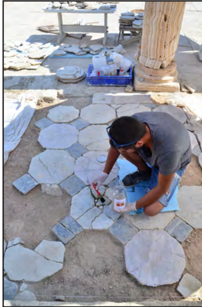
Resim 2 - Opus Sectille sağlamlaştırma çalışmaları.
