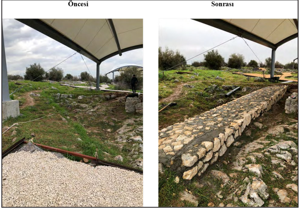
Resim 13: Koruma ve onarım çalışmaları öncesi ve sonrası.
