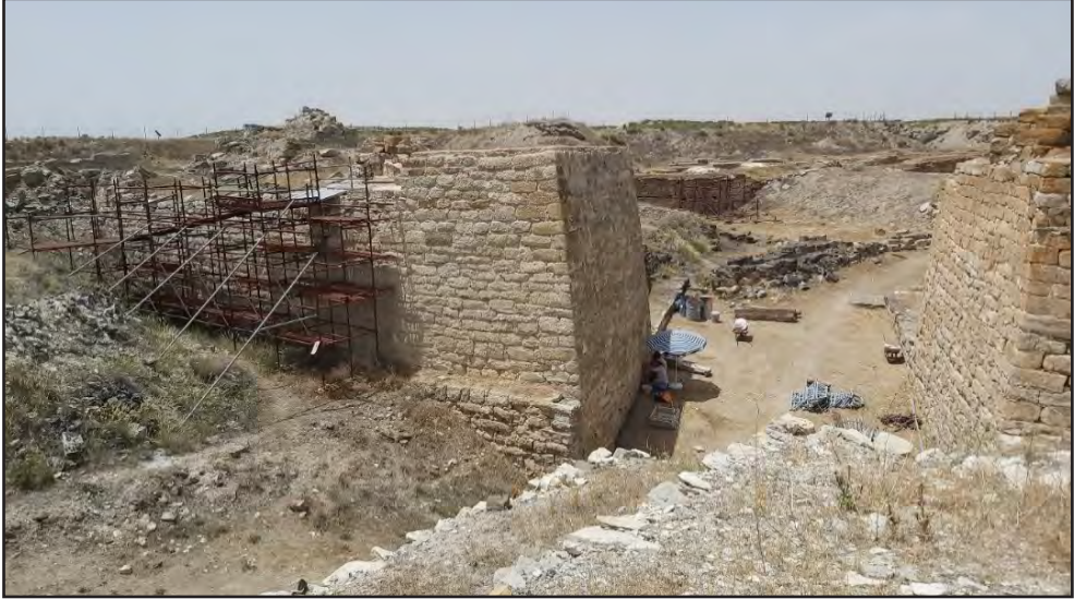
Resim 5: Gordion Batı Kapısı'nın giriş bölümündeki farklı taşlardan örülmüş anıtsal duvar.
