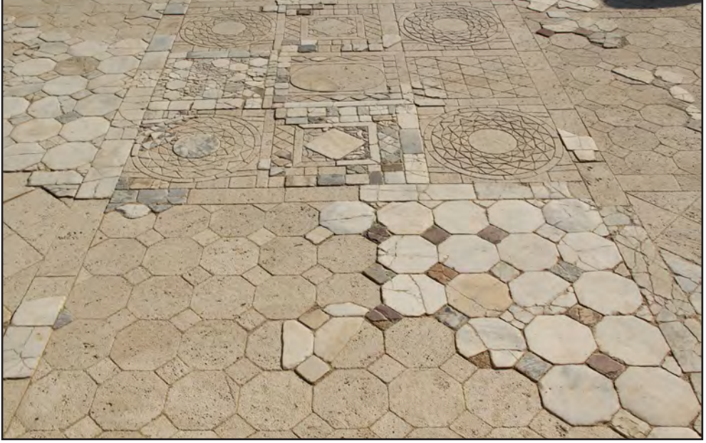
Resim 5 - Opus Sectille döşemelerde doğal taş tamamlama uygulaması.
