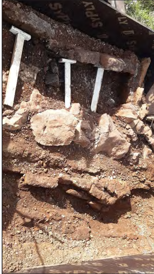
Resim 8: Parçalanmış taş, tuğla ve kerpiç bloklar zamanla dağılmıştır.
